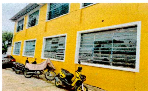
Foto 3: Sustitución de vidrios
