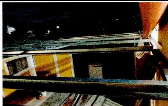
Foto 2: Sustitución de Estructura de techo costanera galvanizada
