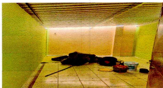
Foto 5: pintura de muros interiores
