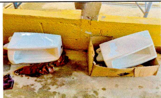
Foto 6: Sustitución de mingitorios
