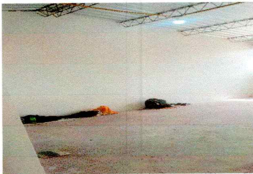
Foto 3: repello y cernido de paredes
