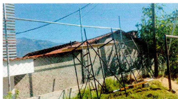
Foto 6: mejoramiento de cerco o muro perimetral
