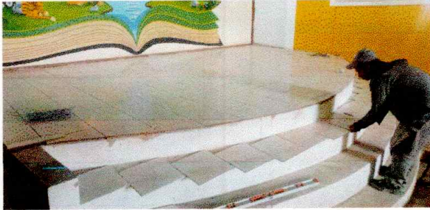
Foto 1: Sustitución de piso de torta
