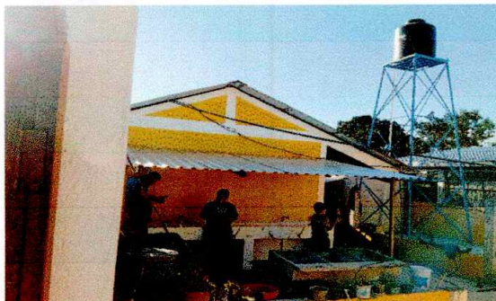
Foto1: sustitución de lamina troquelada
