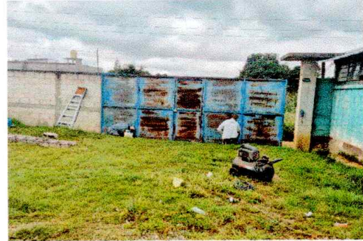
Foto 2: Mantenimiento a portón de metal
