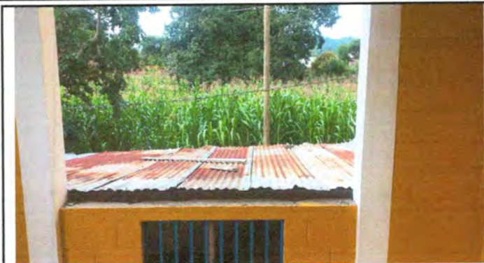
Foto 7 cubierta de lámina
