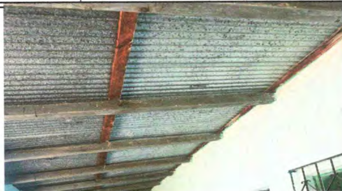
Foto 8 estructura de techo
