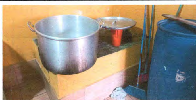
Foto 5 reparación o sustitución de area de cocina
