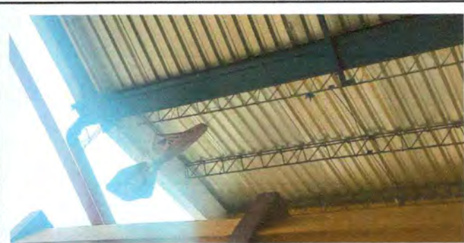
Foto 10 canales y bajadas de agua pluvial
