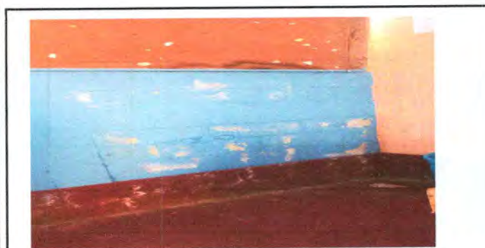
Foto 11 pintura de muros interiores
