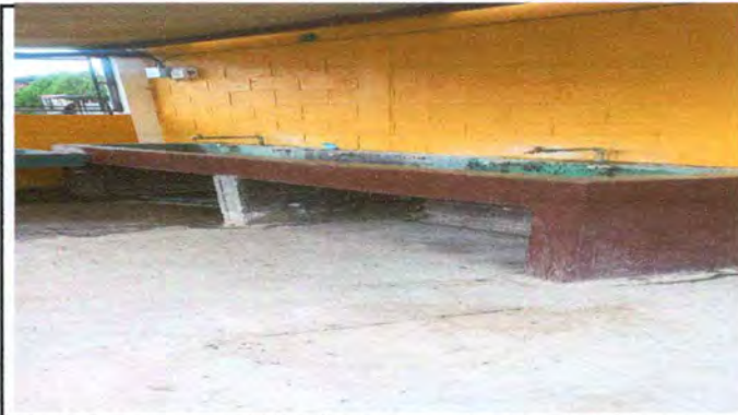
Foto 4 Sustitución o reparación de azulejo
