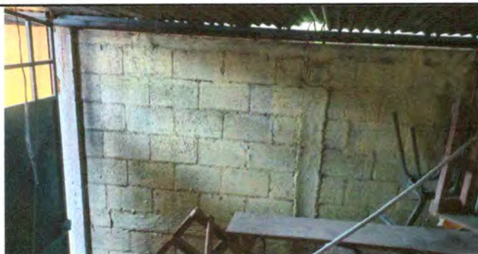
Foto 3 reparación de sernido y repello
