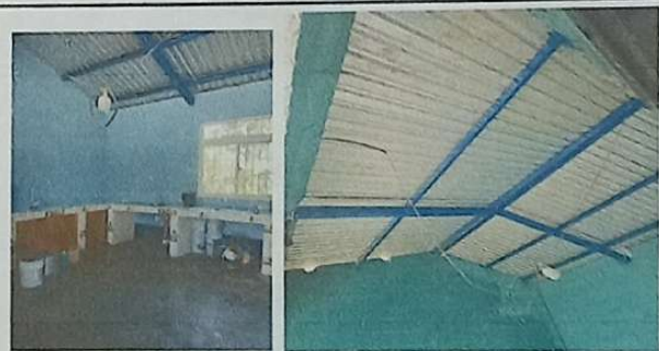
Foto 6: MEJORAMIENTO DE SOPORTE DE METAL Y LÁMINA, MEJORAMIENTO DE VENTANAS
