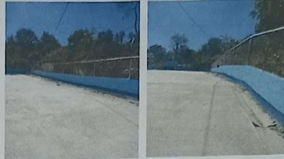
Foto 2: CERCO O MURO PERIMETRAL EN BUEN ESTADO CON EL MEJORAMIENTO
