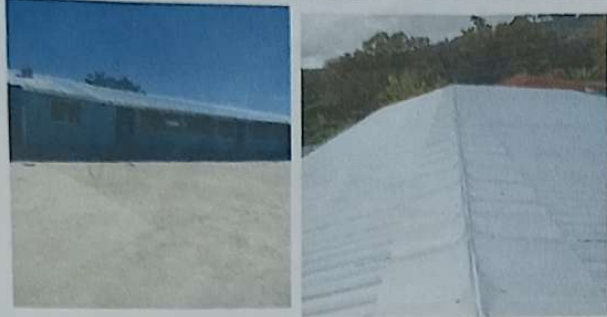
Foto1: TECHO DE AULAS EN BUEN ESTADO CON EL MEJORAMIENTO
