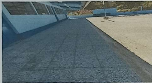
Foto 3: PISO ARREGLADO CON LA SUSTITUCION
