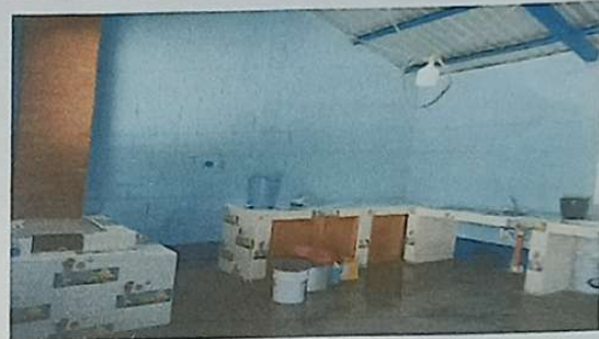
Foto 4: FINALIZACION DE MEJORAMIENTO DE PLANCHA Y MUEBLE DE CONCRETO
