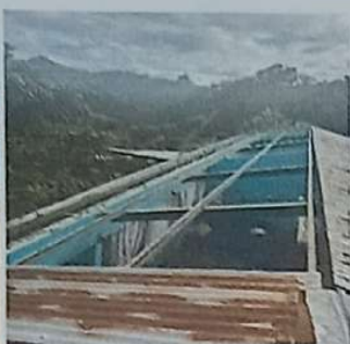
Foto 1: TECHO DE AULAS EN MAL ESTADO Y CON ALGUNOS AGUJEROS
