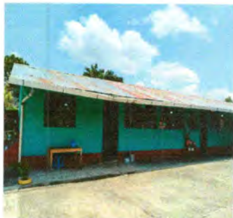
Foto1: TECHO DE AULAS EN MAL ESTADO Y CON ALGUNOS AGUJEROS
