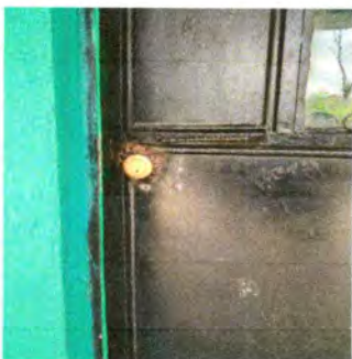
Foto 5: PUERTA DE METAL CON CHAPA EN COCINA A PUNTO DE CAERSE Y MUY DETERIORADA
