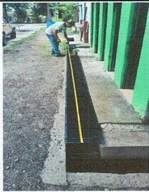
Foto 3: Resultado de las zanjas
