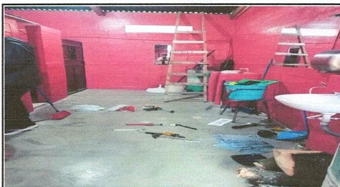
Foto 4: Sustitución de accesorios para sanitarios
