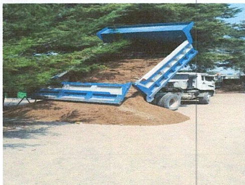
Foto 1: Entrega de camionada de arena para utilizar en las diferentes trabajos.
