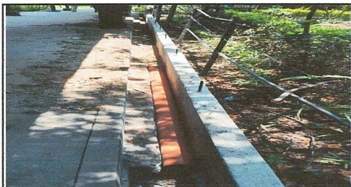
Foto 6: Reparación de la sanja y tubería de los jardines frente a dirección
