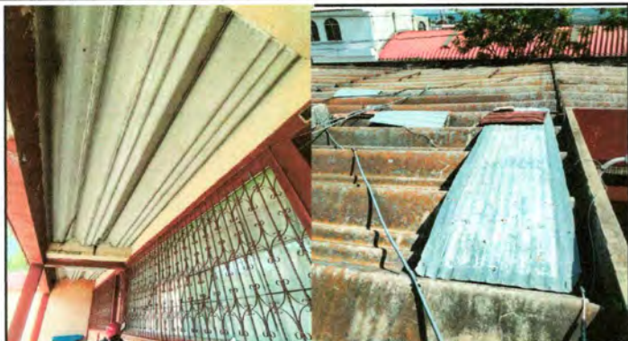
Foto1: Sustrucción por lámina troquelada aluzinc calibre 26
