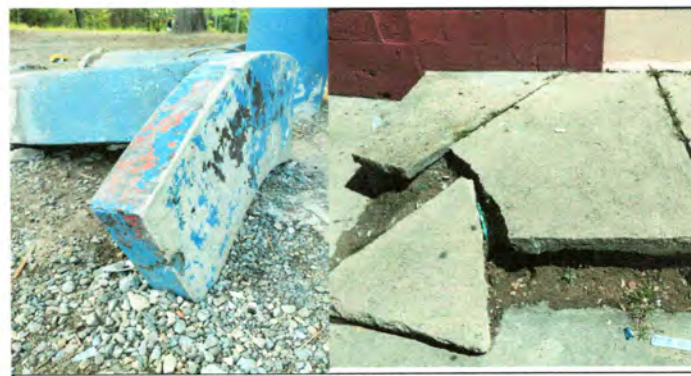
Foto 6: Sustrucción de piso de torta y banca de concreto.
