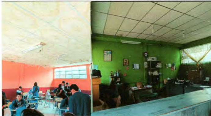
Foto 2: Sustrucción de estructura de soporte
