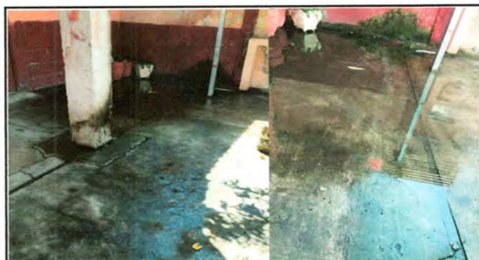
Foto 3: Reparación de cuneta de concreto
