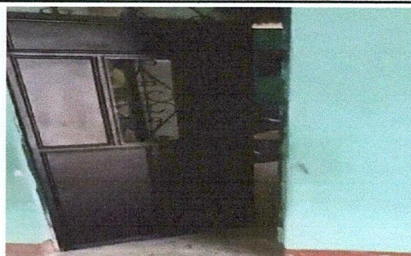
PUERTA PINTADA, Y COLOCACIÓN DE CHAPA NUEVA.
