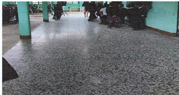
PISO TERMINADO DEL CORREDOR DE LA EORM.
