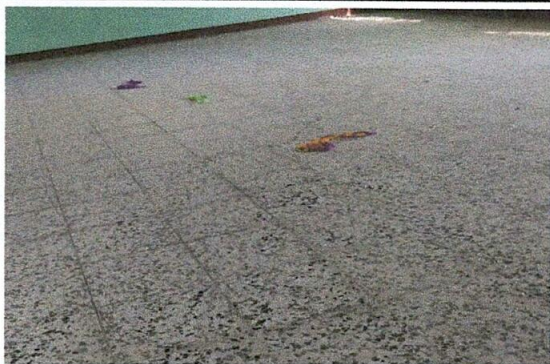
PISO TERMINADO DEL AULA DE PRIMERO SECCIÓN A.
