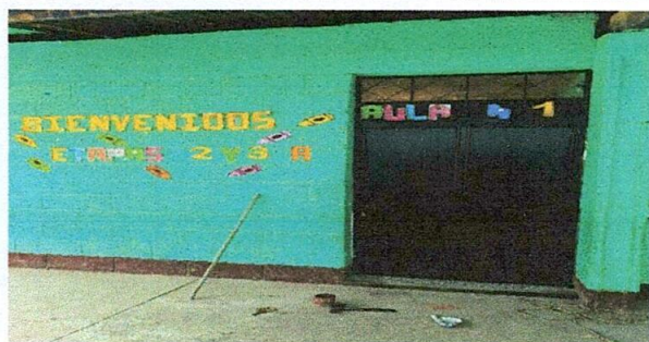
PUERTA CON REMOZAMIENTO DE PINTURA Y COLOCACIÓN DE CHAPA NUEVA.
