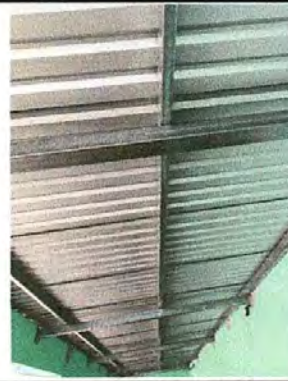
Foto 2: Estructura de metal terminada
