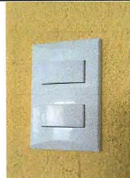
Foto 6: Apagadores dobles nuevos instalados
