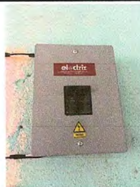
Foto 4: Tablero y flipones nuevos instalados
