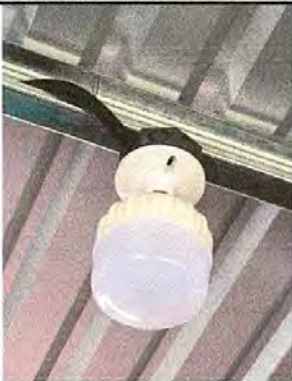
Foto 7: Plafoneras y focos nuevos ya instalados
