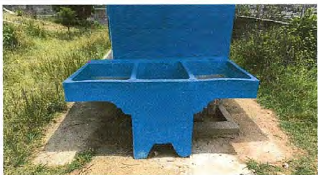
Foto 9: Pila nueva instalada en un lugar adecuado
