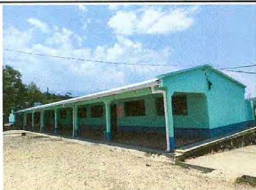
Foto3: Canales y caídas de agua ya instalados
