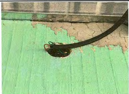
Foto 5: Cambio de cableado eléctrico nuevo ya instalado
