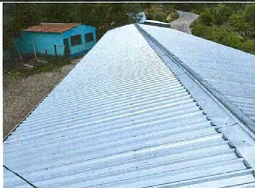
Foto 1: Techo de lámina aluzinc instalada
