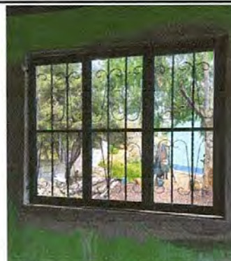
Foto 10: Ventana balcón ya instalada
