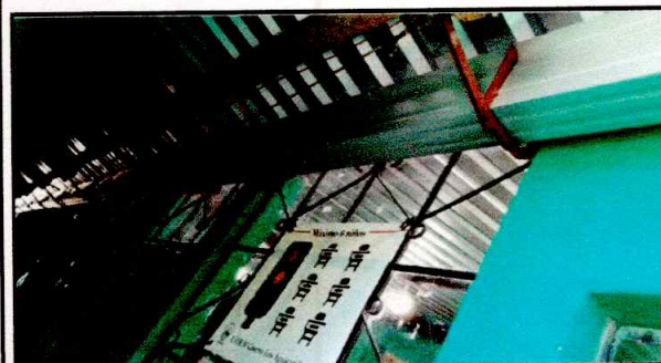
Foto 5: sustitución de canal
