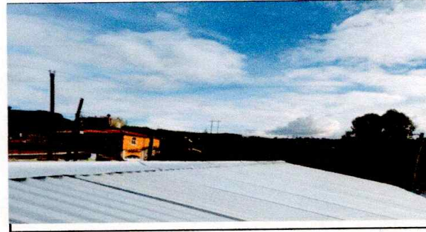
Foto 6: sustitución de capote
