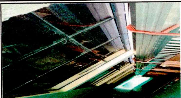
Foto 1: sustitución de canal
