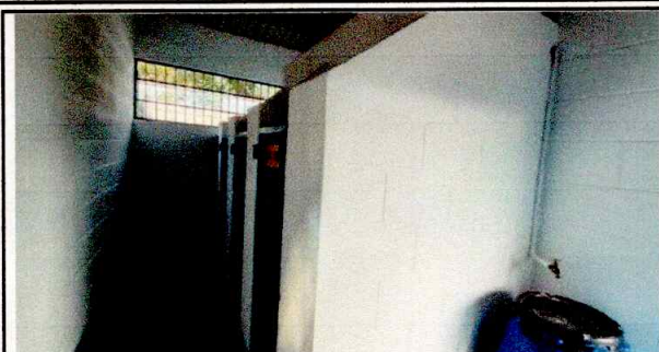
Foto 7: sustitución de pintura
