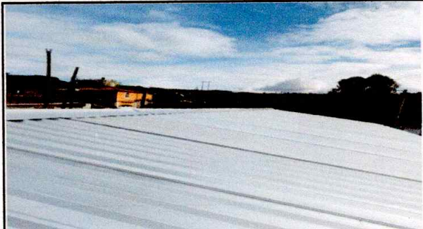
Foto 2: sustitución de lámina
