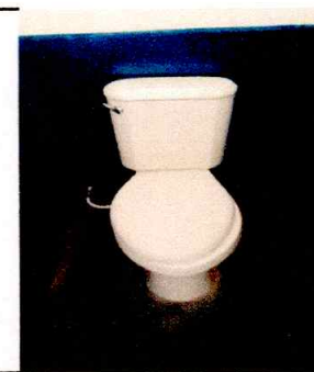
Foto 10: sustitución de inodoros
