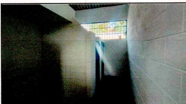
Foto 9: sustitución de pintura en paredes
