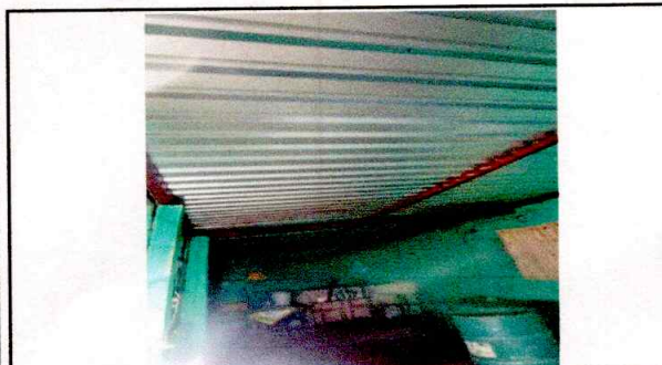
Foto 3: sustitución de soporte de madera
