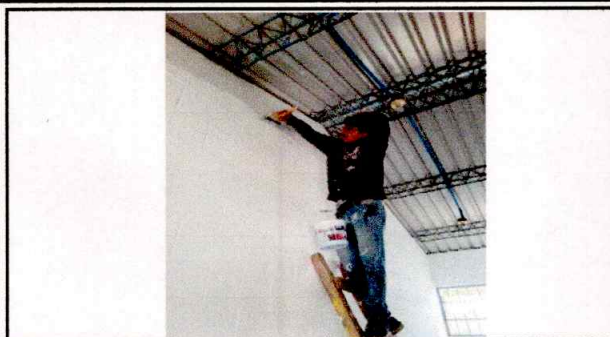
Foto 7: sustitución de pintura
