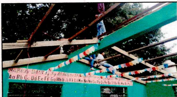
Foto 3: sustitución de soporte de madera
