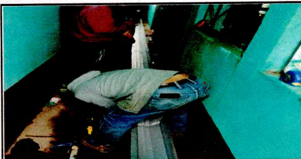
Foto 5: sustitución de canal
