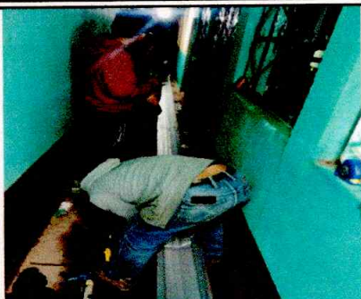
Foto 1: sustitución de canal
