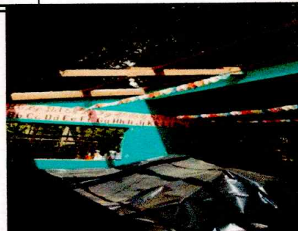
Foto: sustitución de lámina
