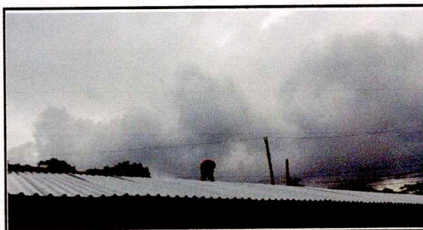
foto 6: sustitución de capote
