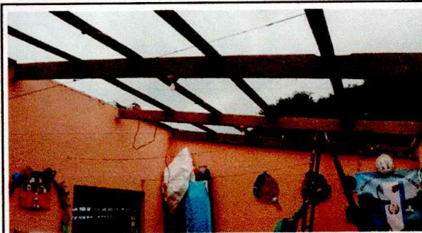
Foto 4: sustitución de lámina
