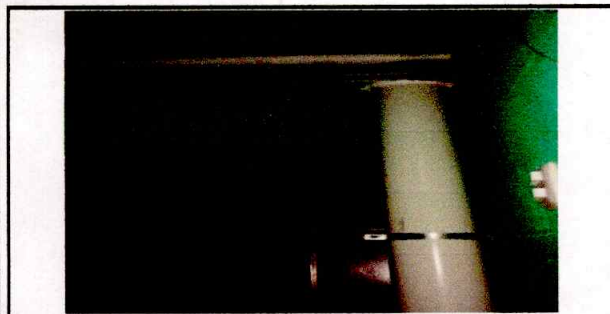
Foto 11: sustitución de bajadas de agua pluvial
