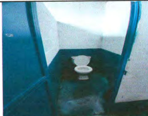
Foto 10: sustitucion de inodoros
