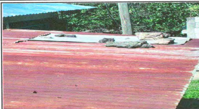
Foto 2: sustiucion de lammina
