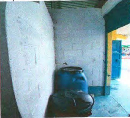
Foto 7: sustitucion de pintura
