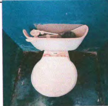
Foto 8: Sustitucion de inodoros
