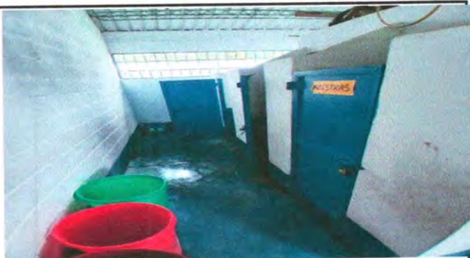
Foto 9: sustitucion de pintura en paredes
