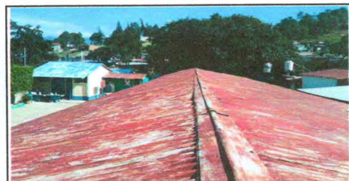
Foto 6: sustitucion de capote.
