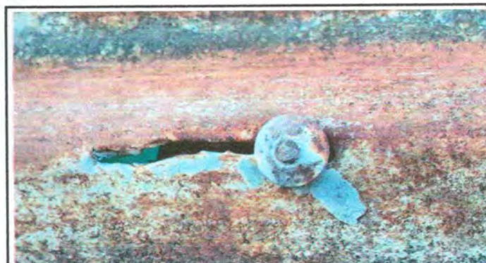
Foto 4: sustitucion de elementos de fijacion.
