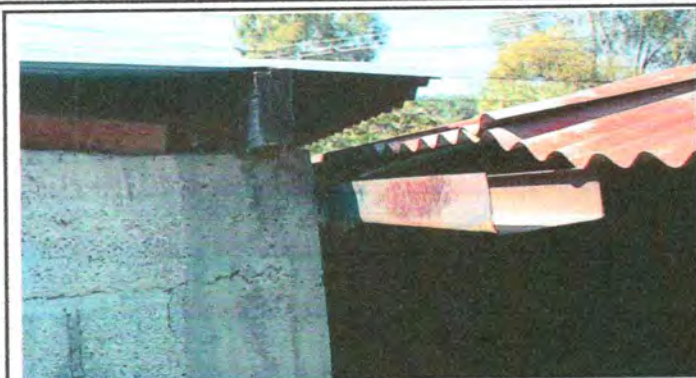
Foto 1: Sustitucion de canal.
