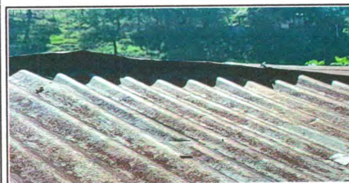
Foto 5: Sustitucion de soporte de capote.
