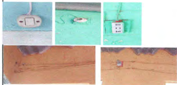
Foto 4: Reparacion de sistema electrico
