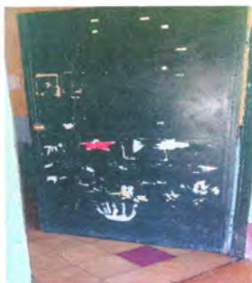
Foto 3: Mantenimiento de puertas de metal
