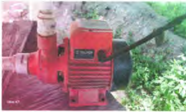
Foto 3: Sustrucion de bomba de agua
