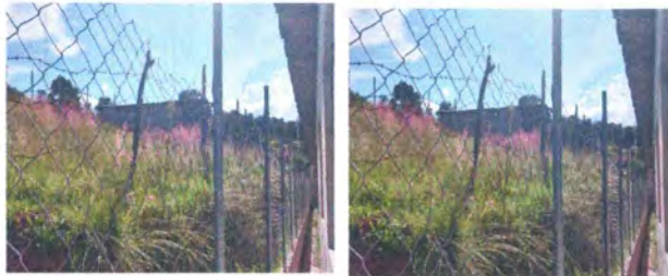
Foto 3: Reparacion de muro perimetral
