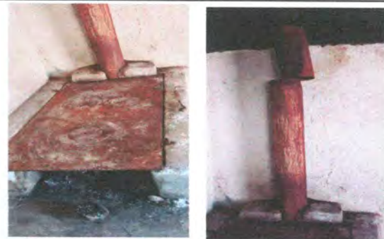
Foto 6: Sustitucion de estufa rural
