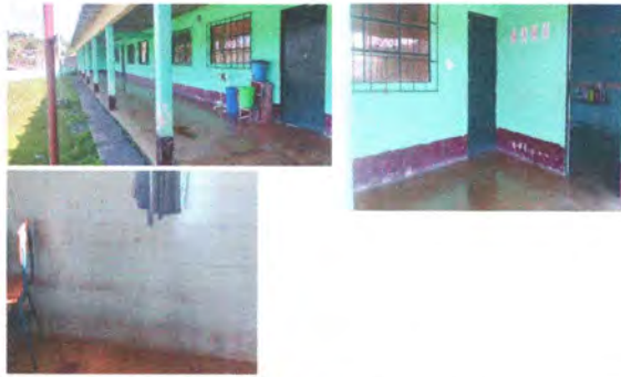
Foto 1: Pintura de exteriores e interiores
