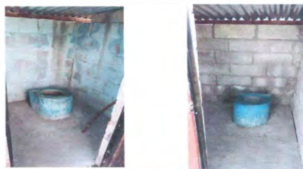
Foto 6: Sustitucion de servicios sanitarios
