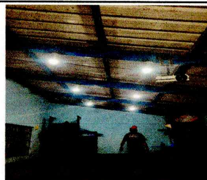
Foto 4: Sustitucion de lámparas de balastro
