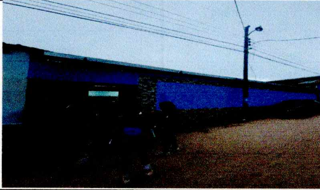
Foto7: Mejoramiento de pintura
