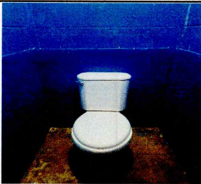
Foto 9: Mejoramiento de pintura
