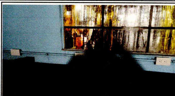
Foto 2: sustitucion de tomas de corriente.
