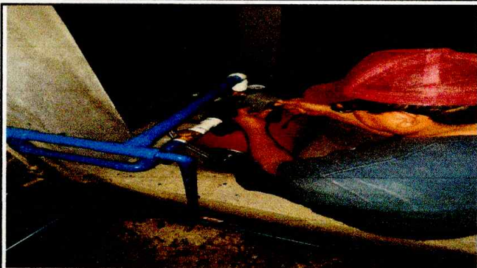
Foto 1: sustitucion de hidroneumatico
