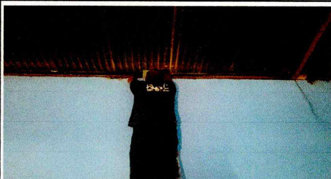
Foto 3: Sustitucion de acometidas
