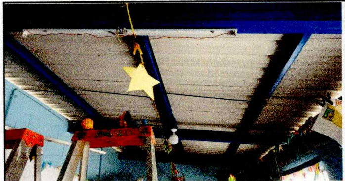
Foto 4: Sustitucion de lámparas de balastro
