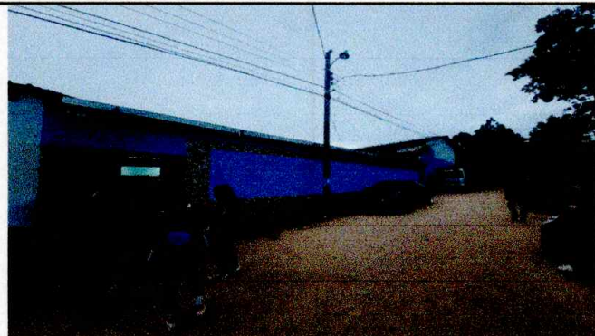
Foto 7: Mejoramiento de pintura
