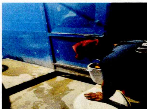
Foto 9: Mejoramiento de pintura
