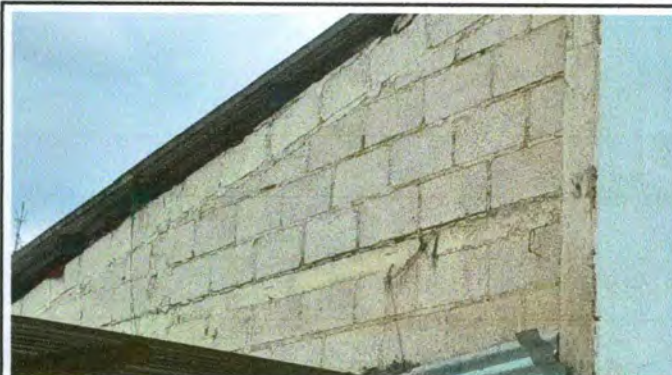
Foto 8: mejoramiento de cubierta.
