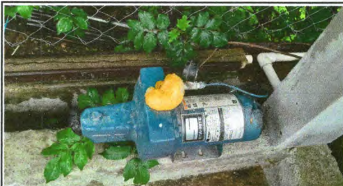
Foto 1: sustitucion de hidroneumatico
