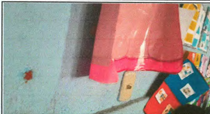
Foto 2: sustitucion de tomas de corriente.
