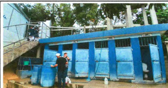
Foto 9: Mejoramiento de pintura
