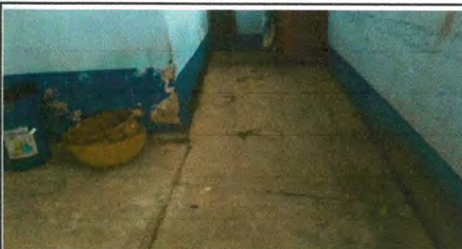
Foto 10: Mejoramiento de pintura
