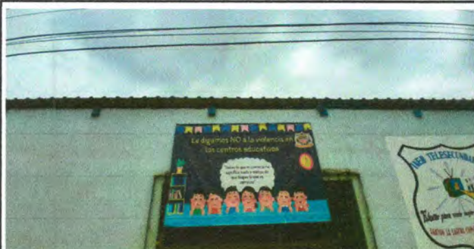
Foto 7: Mejoramiento de pintura
