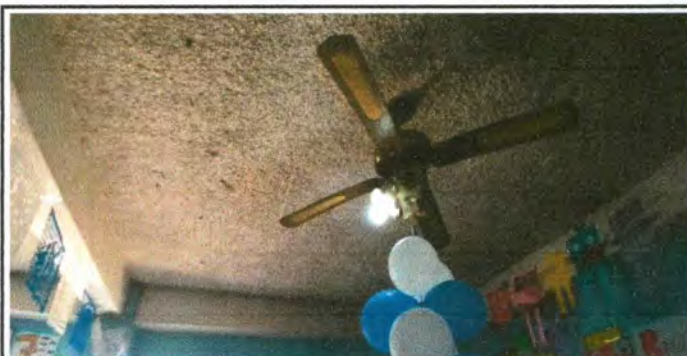
Foto 5: sustitución de lamparas por focos led recargables
