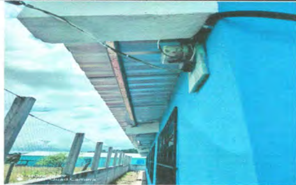
FOTO 4: FLIPON EN MALAS CONDICIONES
