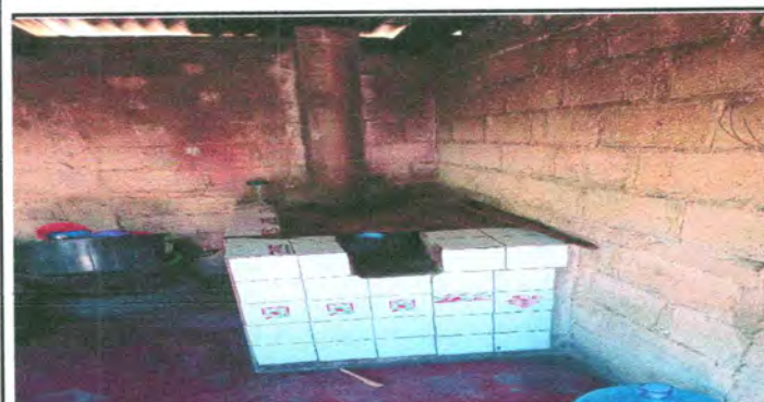
Foto 5: Sustitución de estufa rural
