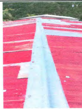
Foto 18: Sustrucción de capote de lámina para lámina troquelada.
