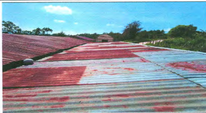
Foto 2: Sustitución de lámina
