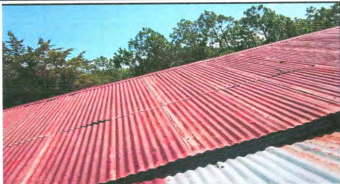
Foto1: Sustitución de lámina
