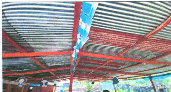
Foto 16: Sustrucción de estructura de soporte de madera por metal.
