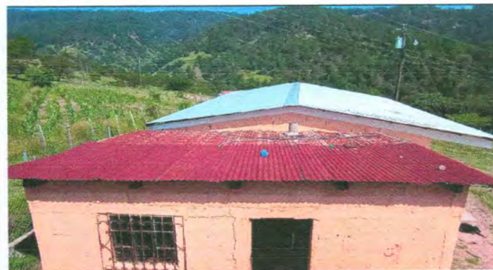
Foto 4: Sustitución de lámina
