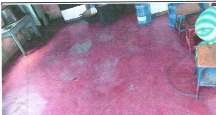
Foto 15: Sustrucción de piso cerámico.
