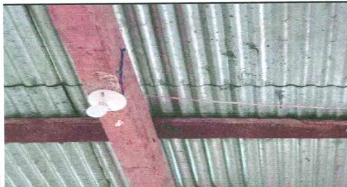
Foto 9: Sustitución de plafoneras
