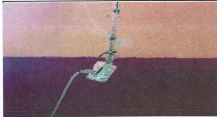
Foto 10: Sustitución tomacorrientes dobles
