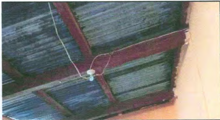
Foto 8: Reparación de cableado eléctrico
