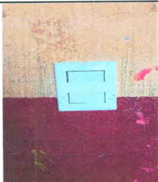
Foto 13: Sustrucción de interruptor doble.
