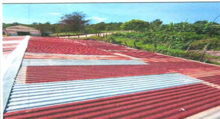
Foto 3: Sustitución de lámina
