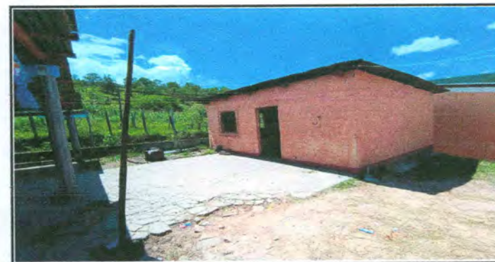
Foto 6: Sustitución de lámina
