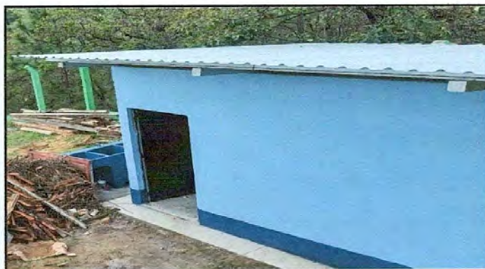
Foto 4: Sustrucción de puerta de madera por puerta de metal de la cocina
