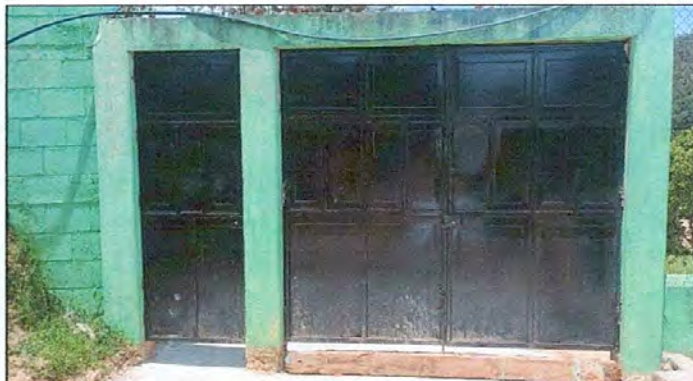
Foto 2: Sustrucción de puertas de metal portón y puerta de entrada principal
