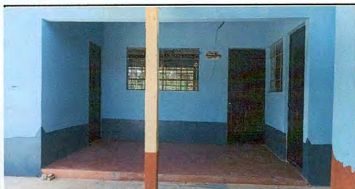
Foto 5: Sustrucción de puertas de madera por puertas de metal de dos aulas y de la Dirección de la Escuela.
