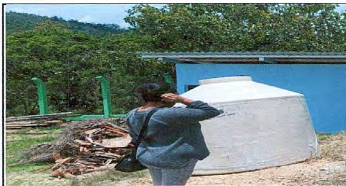
Foto 11: Sustrución de depósito de agua por estar deteriorado.
