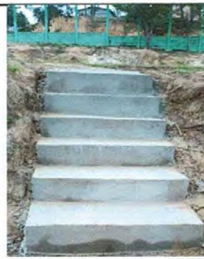
Foto 12: Sustrución de cinco gradas en mal estado
