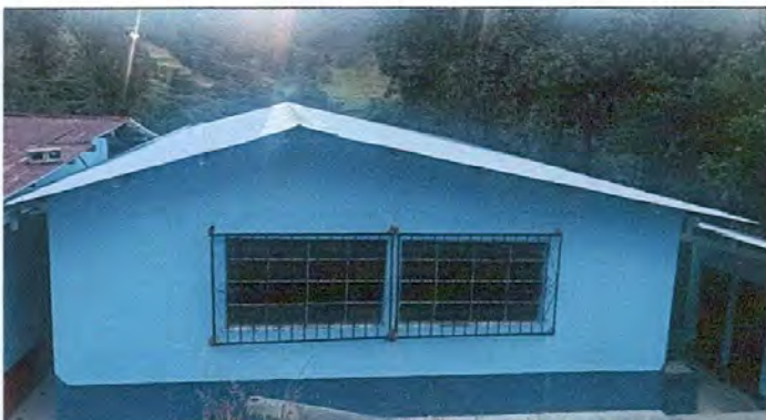
Foto 10: Sustrución de tres balcones deteriorados
