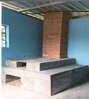
Foto 7: Sustrución de estufa artesanal (base, cambio de plancha)
