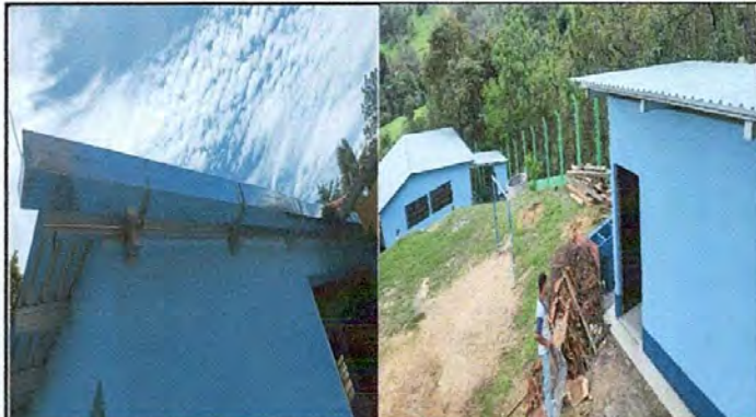
Foto 8: Sustrución de canales y pintura de dos aulas, la dirección, tres sanitarios y la cocina
