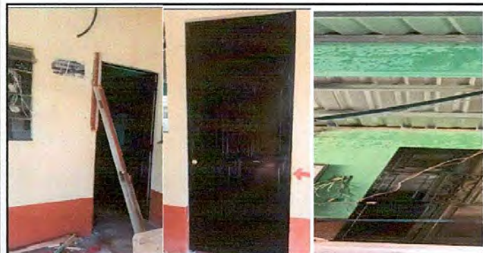
Foto 5: Sustitución de puertas de madera por puertas de metal de dos aulas y de la Dirección de la Escuela.
