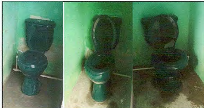
Foto 6: Sustitución de tres servicios sanitarios.
