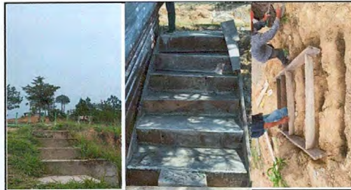
Foto 12: Sustitución de cinco gradas en mal estado
