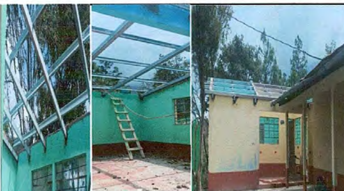
Foto 9: Sustitución de vigas y reglas de madera por costaneras y tubos de metal.
