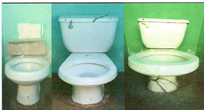
Foto 6: Sustitución de tres servicios sanitarios.
