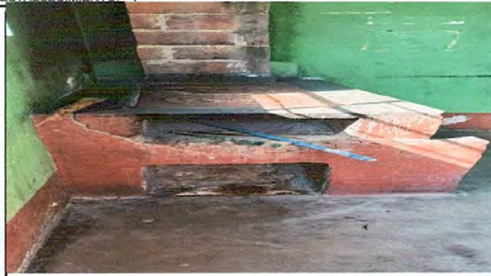
Foto 7: Sustitución de estufa artesanal (base, cambio de plancha)
