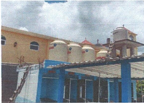
INSTALACIÓN DE 3 TINACOS DE AGUA POTABLE PARA COCINA DE 1100 LITROS CADA UNO
