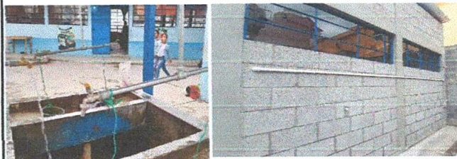
SUSTITUCIÓN DE TUBERÍA DE DRENAJE Y AGUA POTABLE
