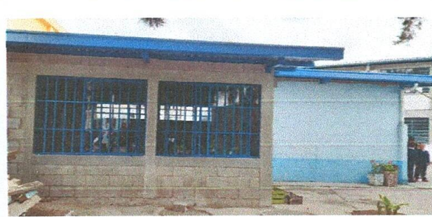
SUSTITUCIÓN DE LÁMINA POR LÁMINA TROQUELADA CALIBRE 26 Y SUSTITUCIÓN DE ESTRUCTURA SOPORTE METÁLICO
