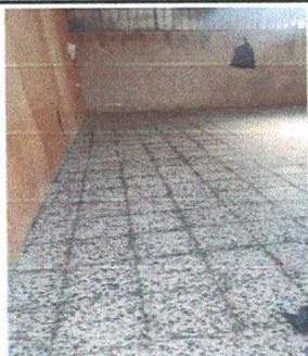
Foto 5: SUSTITUCIÓN DE CEMENTADO DE AULAS, COCINA Y DIRECCIÓN DETERIORADOS, POR PISO DE GRANITO
