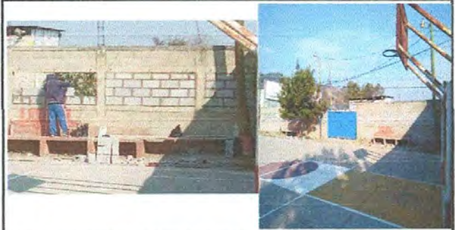
Foto 6: REMOZAMIENTO MURO PERIMETRAL DE LA CANCHA POLIDEPORTIVA
