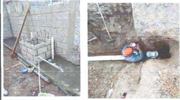
FOTO 4: SUSTITUCIÓN DE TUBERÍA DE DRENAJE Y AGUA POTABLE
