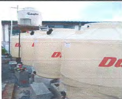
FOTO 7: INSTALACIÓN DE TINACOS
