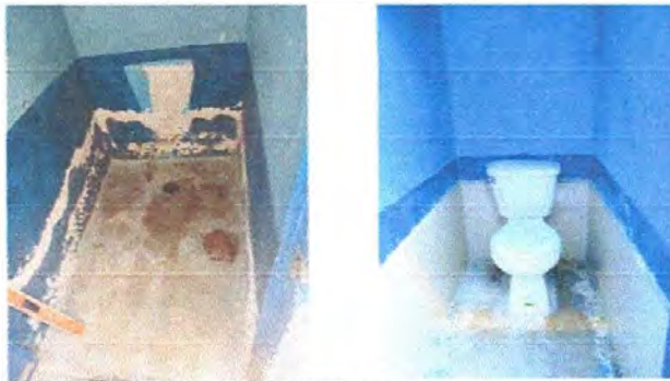
FOTO 3: SUSTITUCIÓN DE 5 INODOROS Y COLOCACIÓN DE ZÓCALO EN LOS MISMOS
