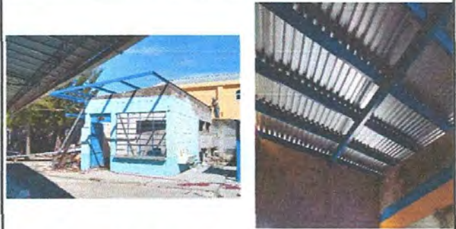
FOTO 2: SUSTITUCIÓN DE LÁMINA Y ESTRUCTURA DE SOPORTE
