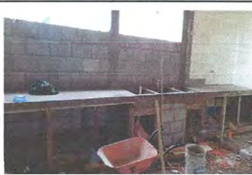
FOTO 8: SUSTITUCIÓN GABINETE COCINA
