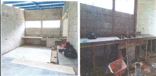
FOTO 1: MEJORAMIENTO DE PARED Y REPARACIÓN DE PILA
