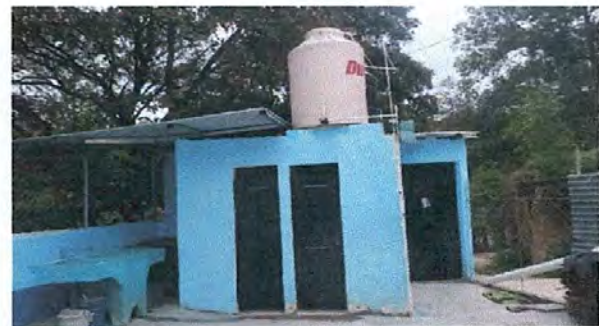
Foto 4: SERVICIO SANITARIO (SUSTITUCIÓN DE LÁMINA POR LÁMINA TROQUELADA ALUZAN CALIBRE 26)
