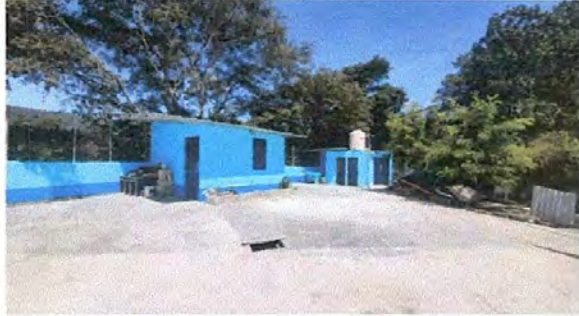
Foto 1: SUSTITUCIÓN DE LAMINA (MAL ESTADO)
