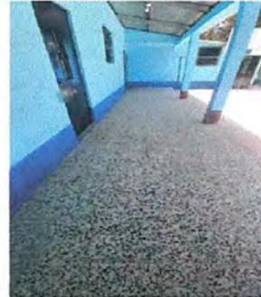
Foto 2: SUSTITUCIÓN DE TORTA DE CEMENTO POR PISO DE GRANITO
