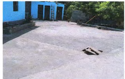
Foto 10. LOSA DE PATIO
