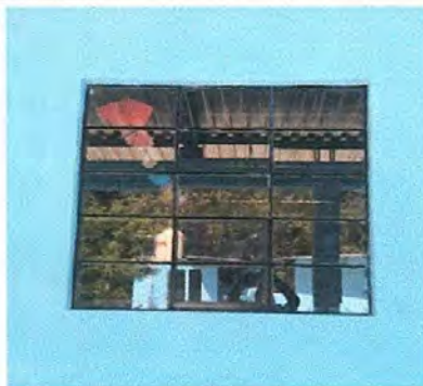
Foto 3: SUSTITUCIÓN DE 6 VENTANAS DE METAL COLOR NEGRO CON VIDRIOS
