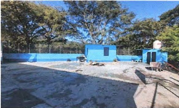
Foto 7. REPARACIÓN DE REPELLO Y CERNIDO DE PAREDES
