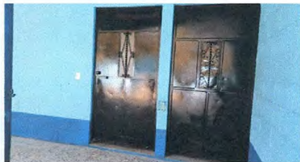
Foto 11. PUERTAS DE METAL (MANTENIMIENTO A ESTRUCTURA)
