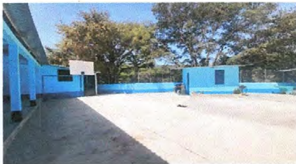
Foto 5: MURO PERIMETRALES (MEJORAR MURO DE CONTENCIÓN)
