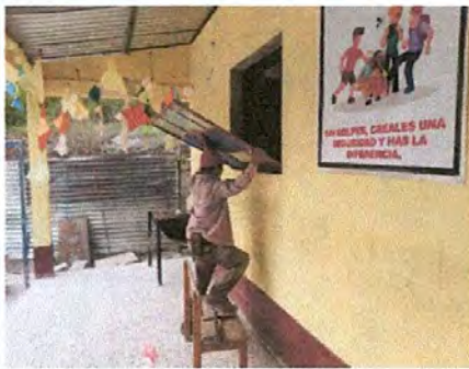
Foto 3: SUSTITUCIÓN DE 6 VENTANAS DE METAL COLOR NEGRO CON VIDRIOS
