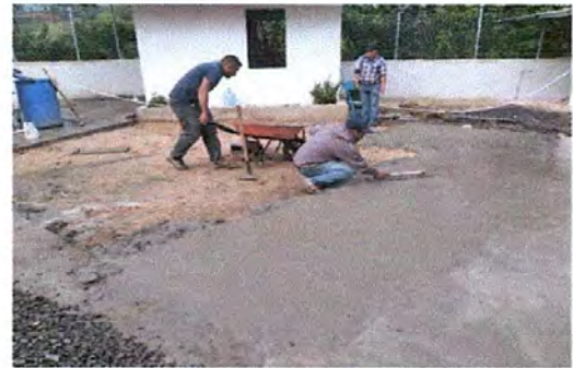
Foto 10. LOSA DE PATIO
