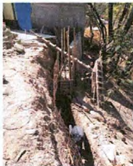
Foto 5: MURO PERIMETRALES (MEJORAR MURO DE CONTENCIÓN)
