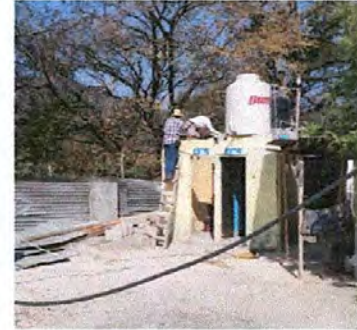
Foto 4: SERVICIO SANITARIO (SUSTITUCIÓN DE LÁMINA POR LÁMINA TROQUELADA ALUZAN CALIBRE 26)
