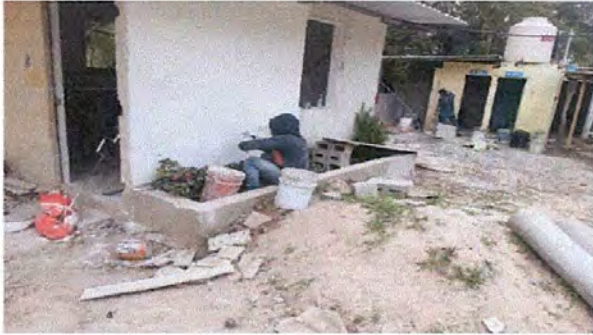
Foto 7. REPARACIÓN DE REPELO Y CERNIDO DE PAREDES
