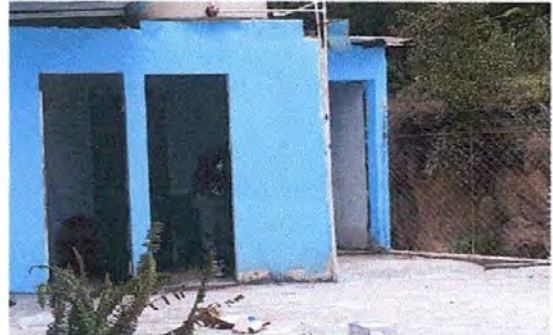
Foto 8. SERVICIOS SANITARIOS Y ACCESORIOS
