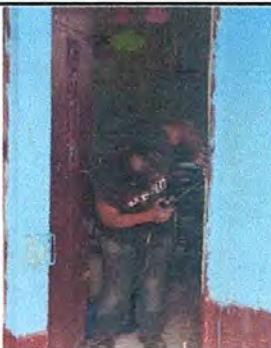
Foto 11. PUERTAS DE METAL (MANTENIMIENTO A ESTRUCTURA)
