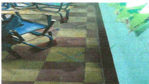
Foto 5: sustitución de piso de concreto
