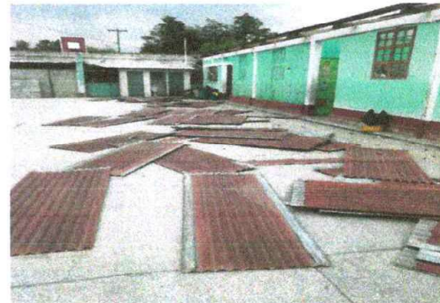
Foto 2: Sustitución de Lámina acanalada por lamina troquelada aluzic
