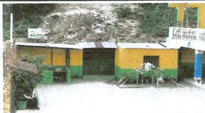
Foto: 3 AMPLIACION DE COCINA
