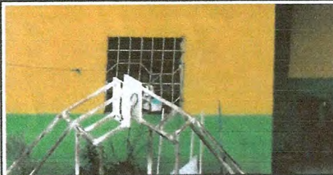
Foto: 6 CAMBIO DE VENTANAS
