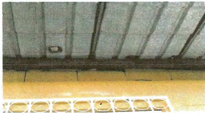
Foto: CAMBIO DE TECHO DE LAMINA
