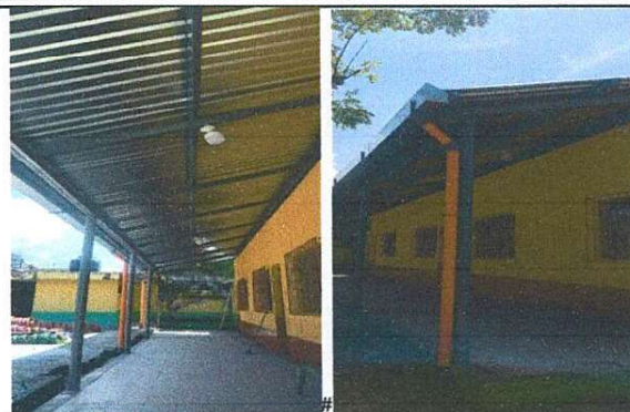
Foto 2: Mantenimiento de estructura de soporte de metal (lijado, aplicación de 2 manos de pintura anticorrosiva) Suministro e instalación de canal calibre 26. Suministro e instalación de cambio de costanera de 4 x 2 pulg.
