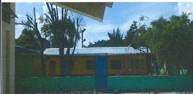
Foto 1: Techo de 2 aulas. Desmontaje de cubierta de lámina existente. Aulas. Suministro e instalación de lámina troquelada Aluzinc calibre 26 (incluye tronillos, sellador)
