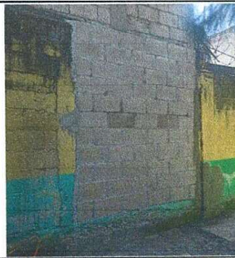
Foto 4: Demolición y reconstrucción de muro perimetral rajado en área de patio trasero.
