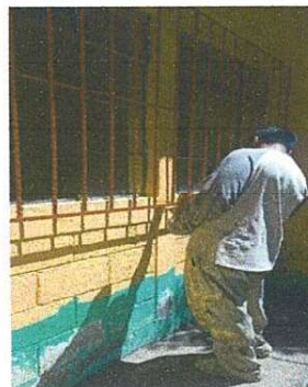
Foto 8: Pintura de balcones de dos aulas
