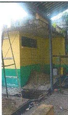
Foto 3: Suministro e instalación de columna de soporte en área de bodega de párvulos
