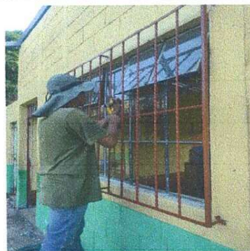
Foto 10: Ventanas fijas convirtiéndose en corredizas, Suministro de vidrios nuevos para ventanas porque están quebrados.
