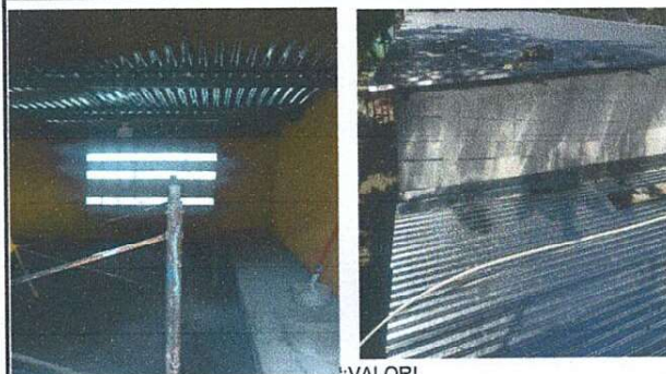
Foto 12: Aplicación de pintura interior y colocación de flashing por humedad y entrada de lluvia.
