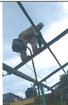
Foto 2: Mantenimiento de estructura de soporte de metal (lijado, aplicación de 2 manos de pintura anticorrosiva) Suministro e instalación de canal calibre 26. Suministro e instalación de cambio de costanera de 4 x 2 pulg.
