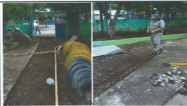
Foto 6: Caminamiento de concreto 20 mts2
