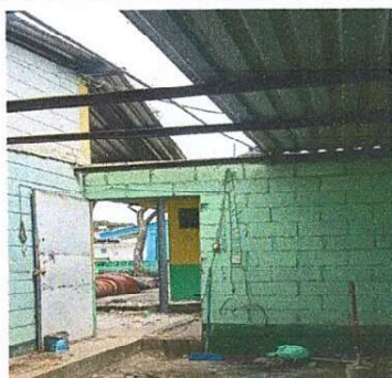
Foto 11: Cambio de Láminas y costaneras.
