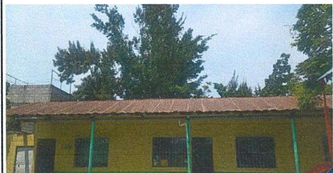
Foto 1: Techo de 2 aulas. Desmontaje de cubierta de lámina existente. Aulas. Suministro e instalación de lámina troquelada Aluzinc calibre 26 (incluye tronillos, sellador)
