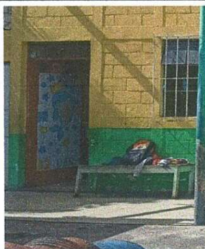
Foto 9: Pintura de puertas de dos aulas
