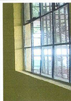
Foto 10: Ventanas fijas que deben convertirse en corredizas, Suministro de vidrios nuevos para ventanas porque están quebrados.
