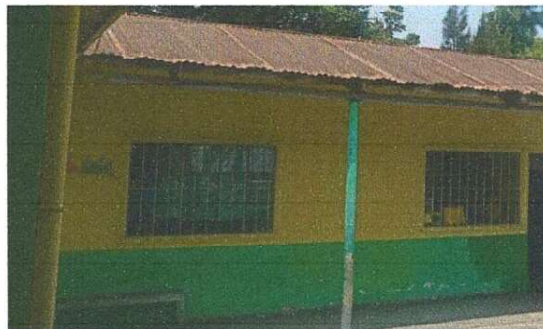
Foto 8: Pintura de balcones de dos aulas
