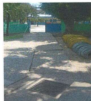
Foto 6: Caminamiento de concreto
