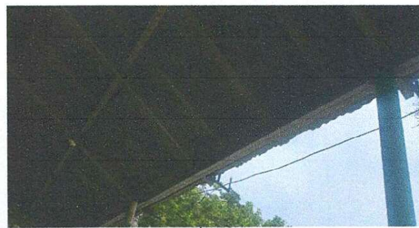
Foto 2: Mantenimiento de estructura de soporte de metal (lijado, aplicación de 2 manos de pintura anticorrosiva) Suministro e instalación de canal calibre 26. Suministro e instalación de cambio de costanera de 4 x 2 pulg.
