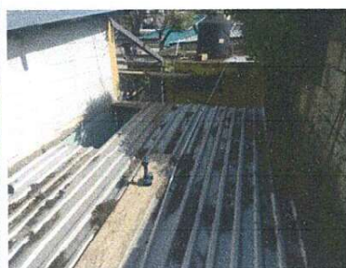
Foto 11: Cambio de láminas y costaneras en bodega.
