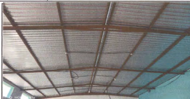
Foto: LÁMINA NUEVA TOTALMENTE COLOCADA SALÓN DE USOS MÚLTIPLES
