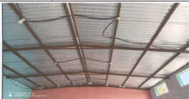
Foto: COLOCACIÓN TOTAL DE TECHO
