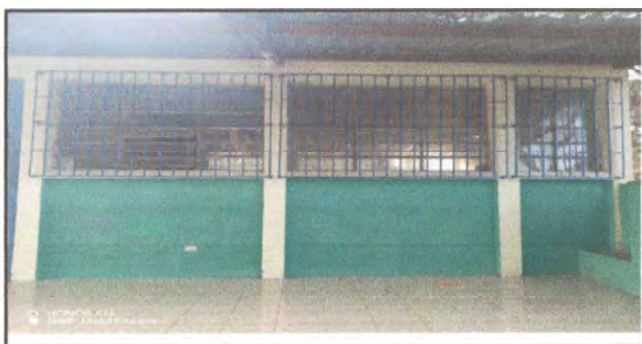
Foto 6 BALCONES COLOCADOS EN SU TOTALIDAD
