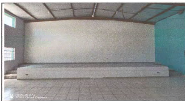
Foto: 4 SALÓN DE USOS MÚLTIPLES TOTALMENTE REPELLADO Y PINTADO
