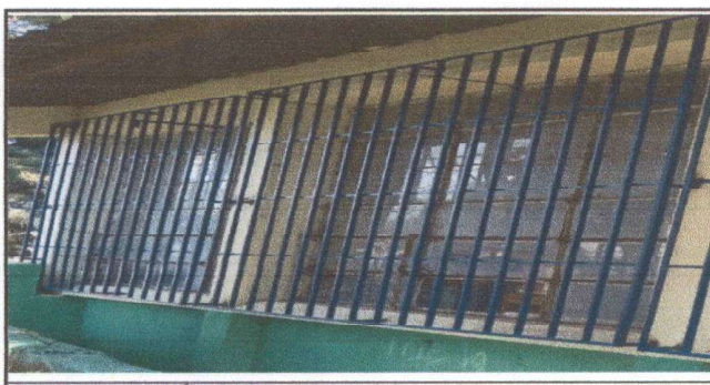
Foto: 5 COLOCACIÓN DE BALCONES
