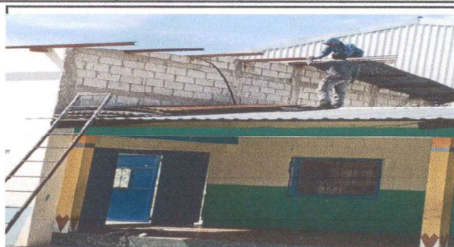
Foto1: .DESMONTANDO LA LÁMINA DAÑADA
