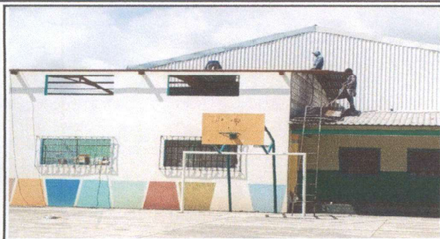
Foto1: .DESMONTANDO LA LÁMINA DAÑADA
