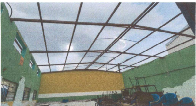
Foto 3: LÁMINA REMOVIDA EN EL SALÓN DE USOS MÚLTIPLES
