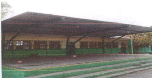
Foto 1: trabajo de la plataforma terminado, pintura de costaneras y lámina cambiada.
