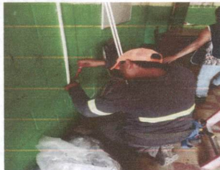
Foto 2: reparación eléctrica de 5 aulas, colocación de conectores y luces para iluminar.
