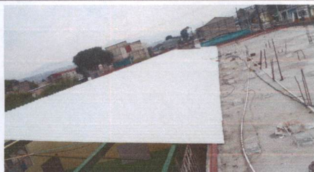
Foto1: colocación de lámina nueva.
