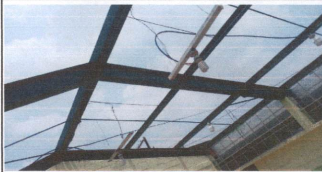
Foto 4: pintura de costaneras.
