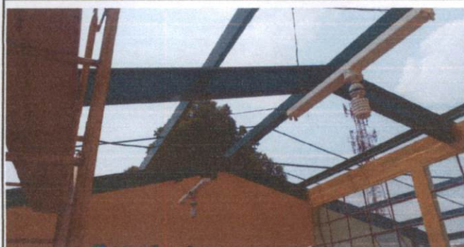
Foto 3: pintura de costaneras.
