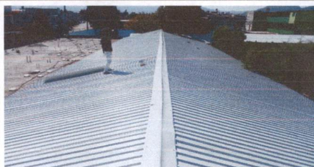
Foto 2: colocación del capote en su totalidad.
