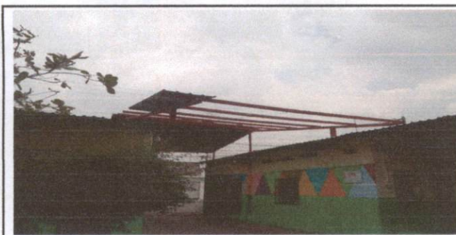
Foto 5: cambio de lámina de la entrada, con lámina que podía usarse, de la que se quitó.
