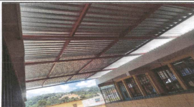
Foto 1: Techo termonado. Se cambió lámina antigua y se colocó lámina troquelada, calibre 26. Se lijaron y pintaron las costaneras.
