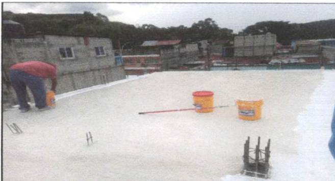
Foto 4: Aplicación de impermeabilizante en terraza para evitar filtraciones de agua.
