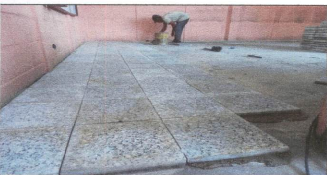
Foto 5: Colocación de piso de granito en los salones de clases.
