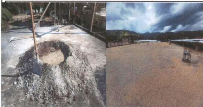
Foto 3: Aplicación de nueva capa de mezcla para reanar la terraza del edificio.
