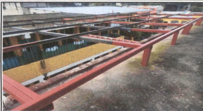
Foto 1: Levantado de lámina deteriorada y aplicación de pintura en costaneras, estructura metálica para colocación de nueva lámina.
