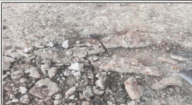
Foto 2: Levantado de ripio sobre terraza dañada, para aplicar nueva capa de mezcla para corregir los pañuelos y evitar la filtración de agua en los techos y paredes de los salones.
