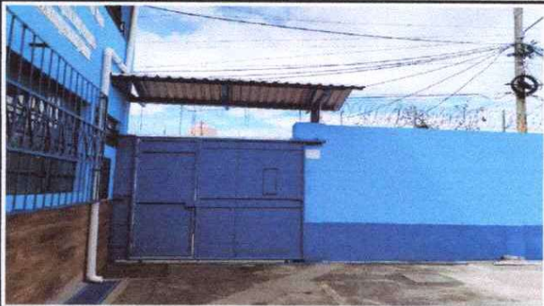
Foto 1: Instalacion de techo para portón, finalizado.
