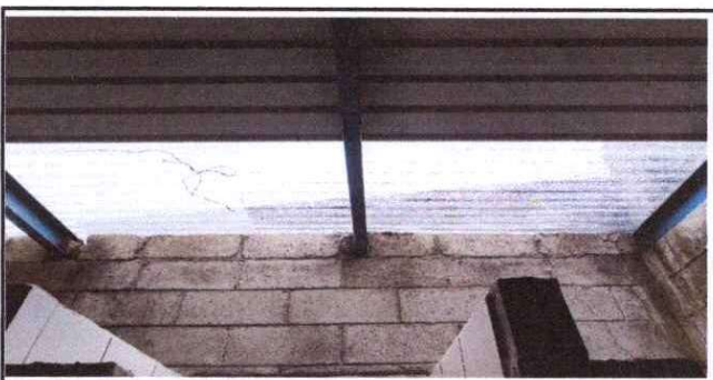
Foto 6: Instalación de lamina ya finalizada.
