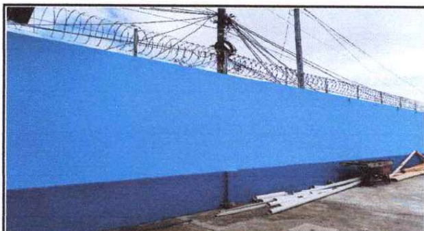
Foto 4: pintura en paredes, finalizado.
