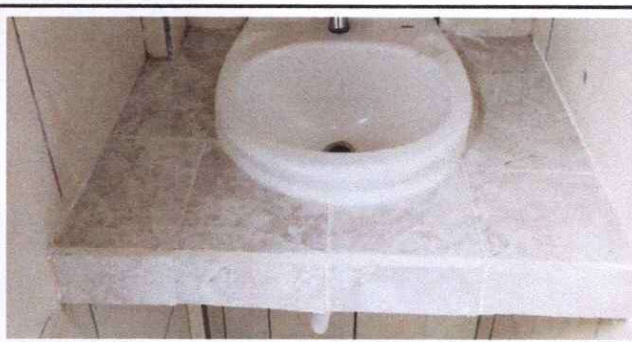
Foto 5: Instalación de azulejo en lavamanos finalizado.
