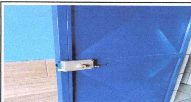
Foto 4: Sustrucción de chapas ya finalizado.
