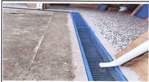
Foto 2: Instalacion de cuneta y rejilla, finalizado.
