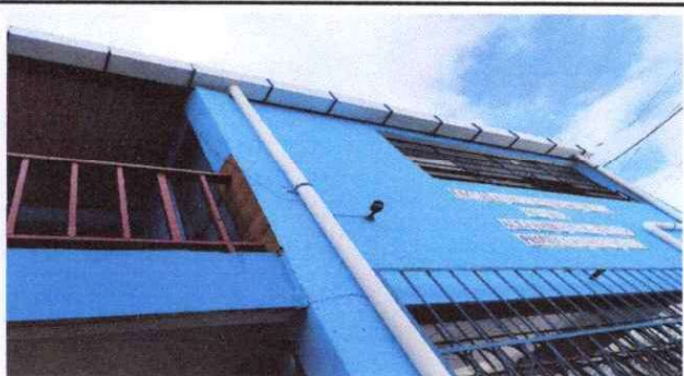
Foto 1: Sustrucción de canal y bajadas de agua ya finalizado.
