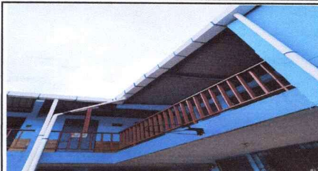
Foto 2: Sustrucción de canal y bajadas de agua ya finalizado.
