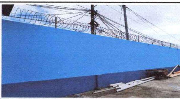
Foto 5: Instalación del razor, finalizado.
