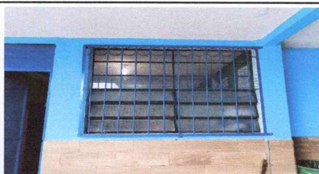
Foto 3: Instalación de balcones ya finalizado.
