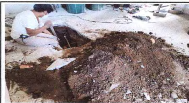
Foto 2: Reparación de drenaje en cocina.
