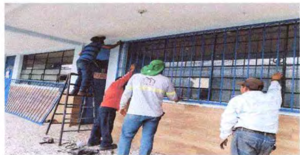
Foto 5: Instalación de balcones.
