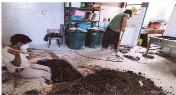
Foto 1: Reparación de drenaje en cocina.
