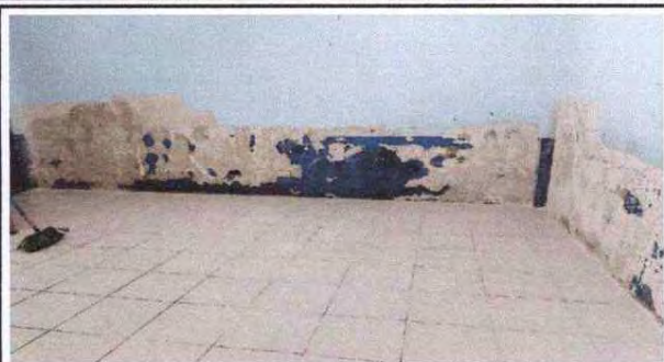
Foto 1: Repello y cernido de paredes de aula.
