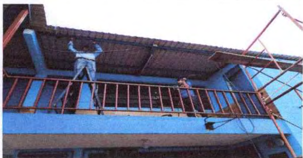
Foto 1: Sustitución de canal.
