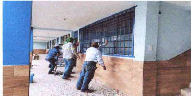
Foto 6: Instalación de balcones.
