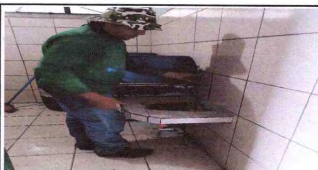
Foto 6: Instalacion de azulejo en lavamanos.
