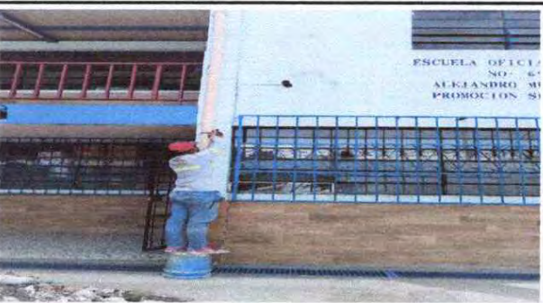
Foto 5: Sustitución de bajadas de agua pluvial.
