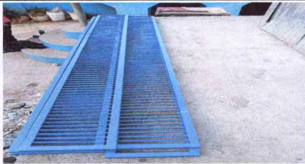
Foto 3: Instalacion de rejilla en cuneta.
