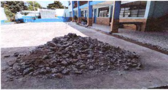
Foto 1: Sustrucción de cuneta en patio.
