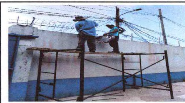
Foto 4: Instalación de alambre espigado y razor.
