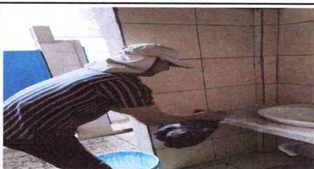
Foto 5: Instalacion de azulejo en lavamanos.
