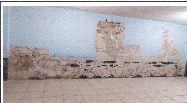
Foto 2: Repello y cernido de paredes de aula.
