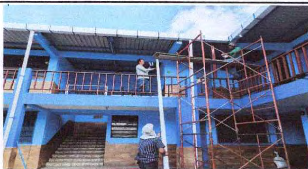
Foto 3: Sustitución de canal.
