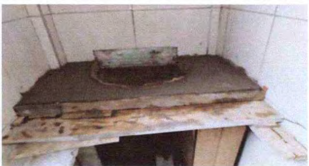
Foto 3: Sustitución de lavamanos.
