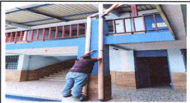
Foto 6: Sustitución de bajadas de agua pluvial.
