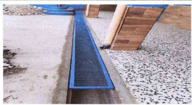
Foto 4: Instalacion de rejilla en cuneta.
