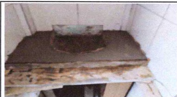
Foto 4: Sustitución de lavamanos.
