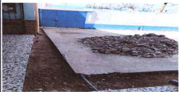
Foto 2: Sustrucción de cuneta en patio.
