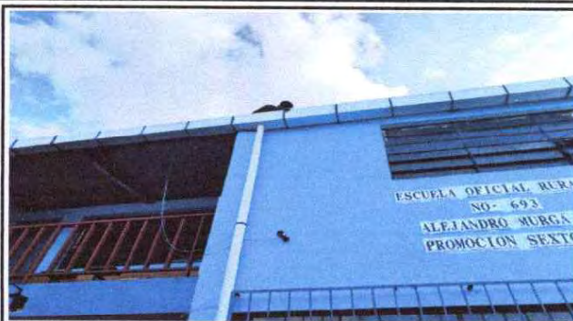
Foto 2: Sustitución de canal.
