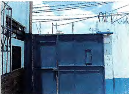
Foto 5: COLOCACION DE DOS LINEAS DE RAIZOR
