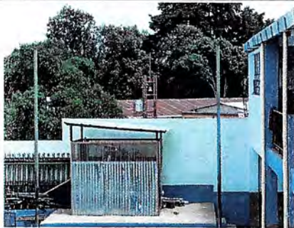
Foto 3: INSTALACION DE ALAMBRE RAIZOR DOS LINEAS
