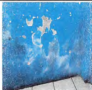
Foto 5: REPARACION DE REPELLO EN PARED + IMPERMEABILIZACION
