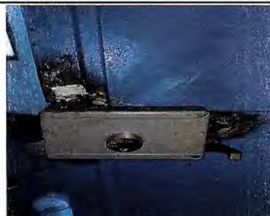
Foto 2: SUSTITUCION DE CHAPAS EN MAL ESTADO
