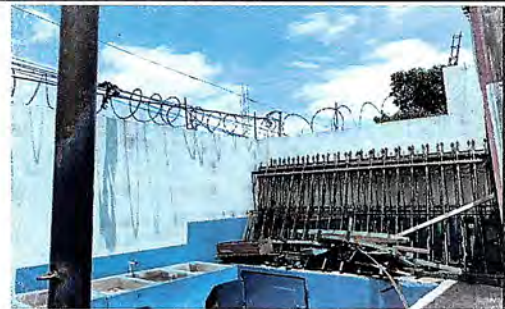
Foto 4: INSTALACION DE ALAMBRE RAIZOR DOS LINEAS
