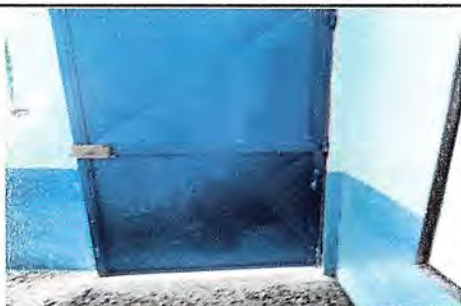
Foto 3: MANTENIMIENTO DE PUERTAS, LIJADO Y PINTADO.
