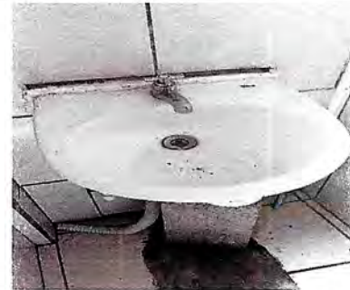
Foto 2: SUSTITUCION DE LAVAMANOS POR LAVAMANOS FUNDIDOS
