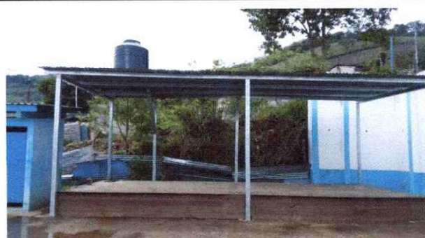
Estructura del esenario de la escuela.
