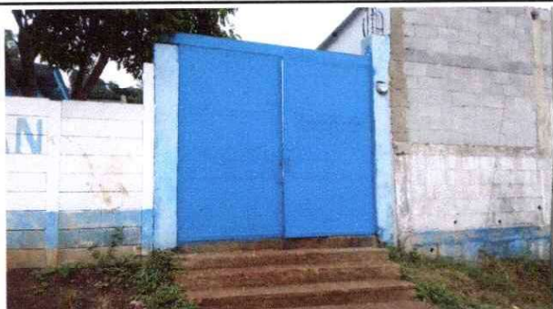
Mantenimiento del porton de la escuela.
