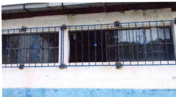
Ventanas de la escuela (balcones instalados).
