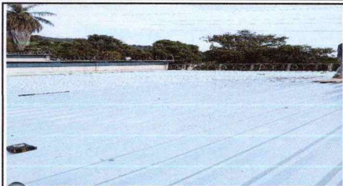
FOTO 1: SUSTITUCIÓN DE 150 METROS CUADRADOS DE LÁMINA EN AULAS, VISTO DE ARRIBA.
