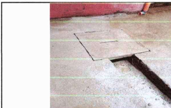
FOTO 6: CAJA DE REGISTRO DE AGUAS PLUVIALES DE 60 X 60 CM. TERMINADA
