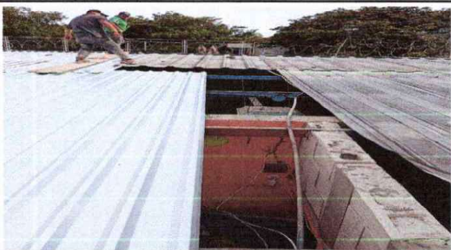
FOTO 4: SUSTITUCIÓN DE 150 METROS CUADRADOS DE LÁMINA TROQUELADA ALUZINC CALIBRE 26.
