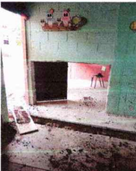
FOTO 2: APERTURA DE PAREDES DE 1.20 X 1.20 M2
