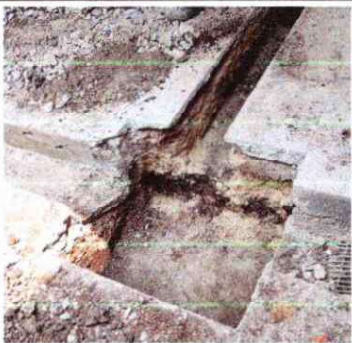
FOTO 5: FABRICACIÓN DE CAJA DE REGISTRO DE AGUAS PLUVIALES 60 X 60 CENTÍMETROS.
