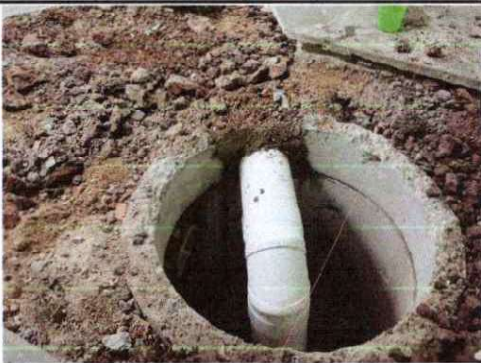
FOTO 3: INSTALACIÓN DE TUBOS PVC DE 8" CON SU RESPECTIVO CODO
