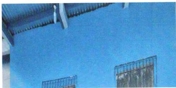
Repello en el área del esenario e instalación de luz eléctrica
