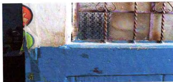
Cambio de vidrios en otra ventana
