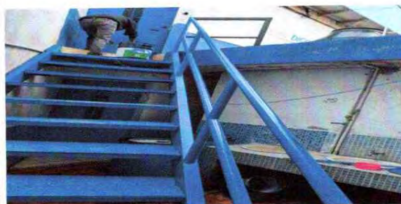
Mantenimiento de todas las gradas y refuerzos
