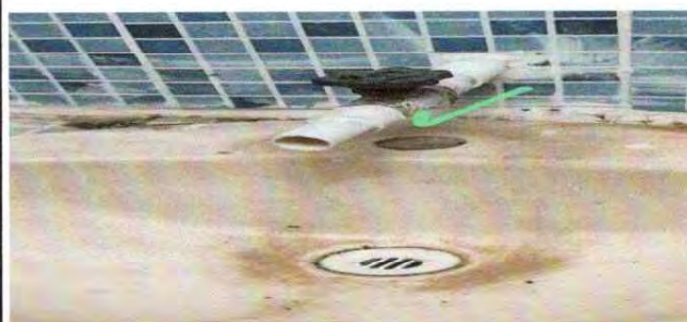
Reparación de fuga de agua
