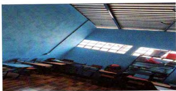
Evidencias de cambio de cables de electricidad, piso, repello y pintura.
