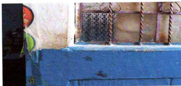
Cambio de vidrios en otra ventana
