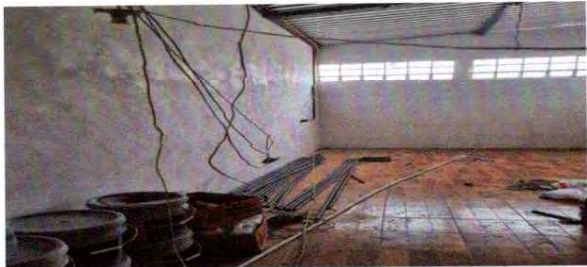
SISTEMA ELECTRICO: en proceso de cambio de accesorios.
