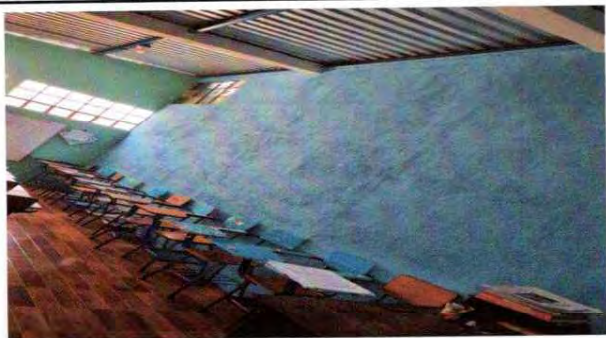
Cambio de vidrios, reportados y que estaban quebrados
