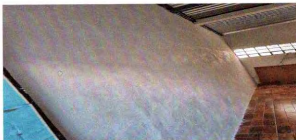
instalación de piso, en salones de clase.
