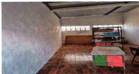
instalación de piso en salones de clase
