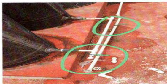
cambio de llaves de paso de agua, que necesitaban cambio
