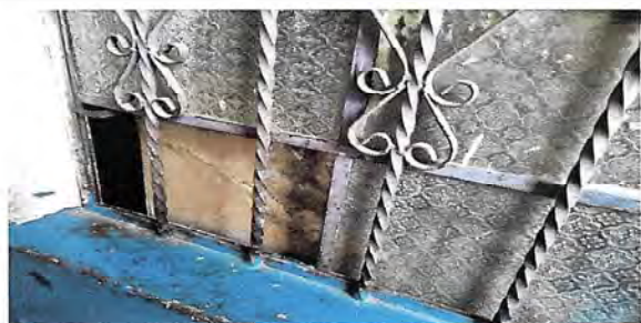
Foto1: Recemplazo de vidrios de ventanas.
