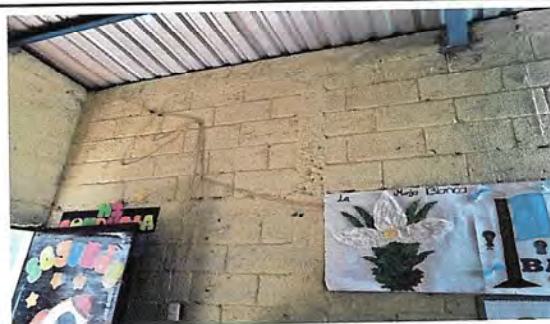
Foto 6: Corrección de área dañada con la electricidad.
