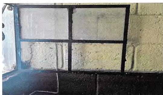
Foto 4: Salón de clases en donde hay dos vidrios quebrados que se cambiarán.
