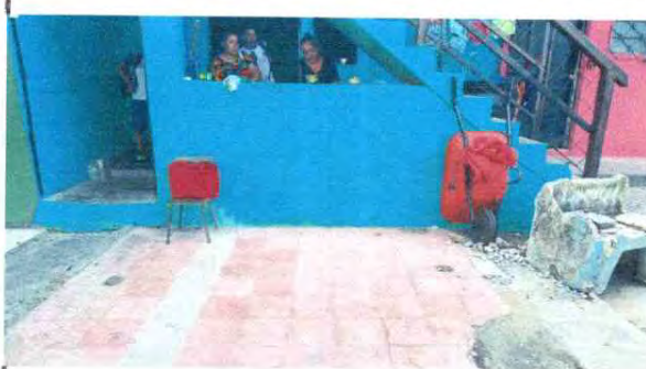
Foto 4: Colocacion de 2 pilas
