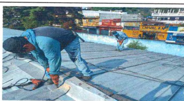
Foto 6: Desmintando el techo
