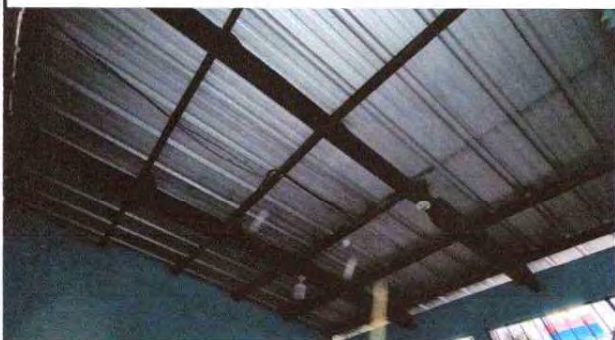
Foto1: sustitucion de vigas y laminas
