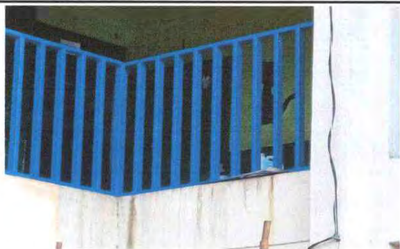
Foto1: pintura de barandas
