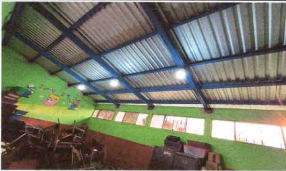
Foto1: sustitucion de vigas y laminas
