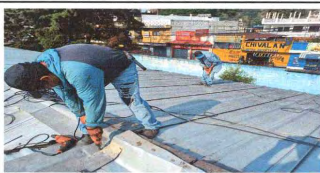
Foto 6: Desmintando el techo
