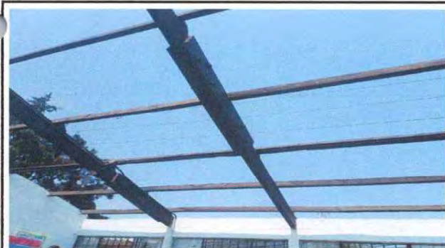
Foto 5: desmontando la vigas de madera
