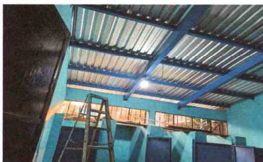
Foto 3: techo de los sanitarios
