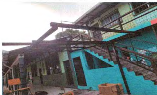
Foto 2: techo para las pilas
