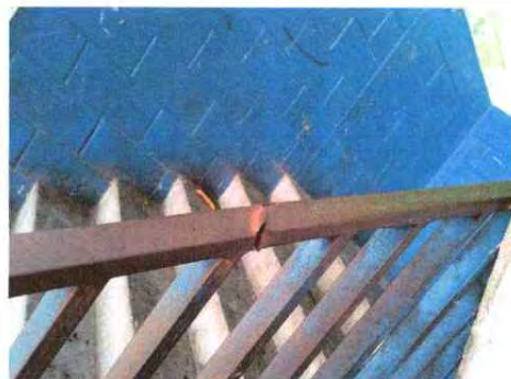
Foto 2: sustitucion de baranda de gradas
