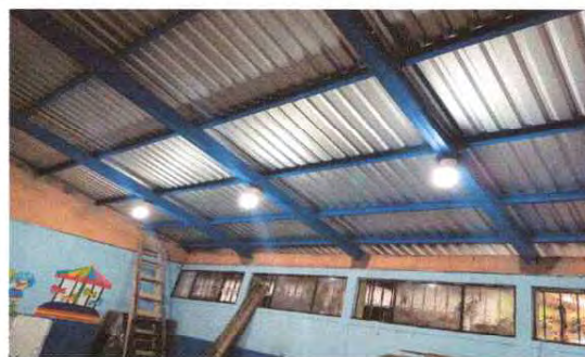
Foto 4: instalacion de laminas y estructura metalica e intalacion electrica
