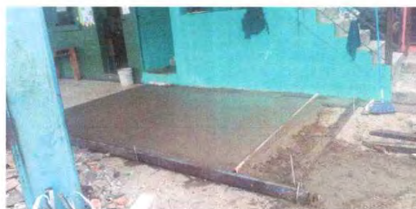
Foto 6: fundicion de tota para colocar las pilas
