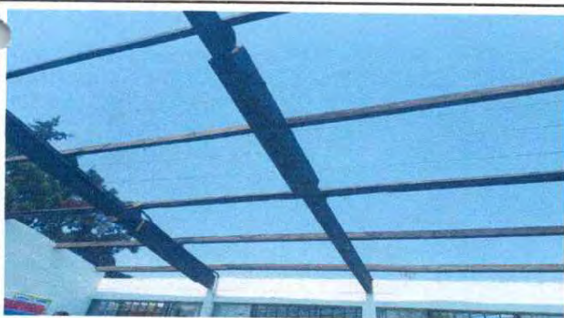
Foto 5: desmontando la vigas de madera
