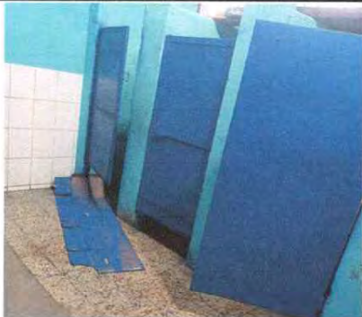
Foto 3: lijado y pintado de puertas de sanitarios
