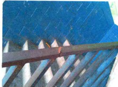
Foto 2: sustitucion de baranda de gradas
