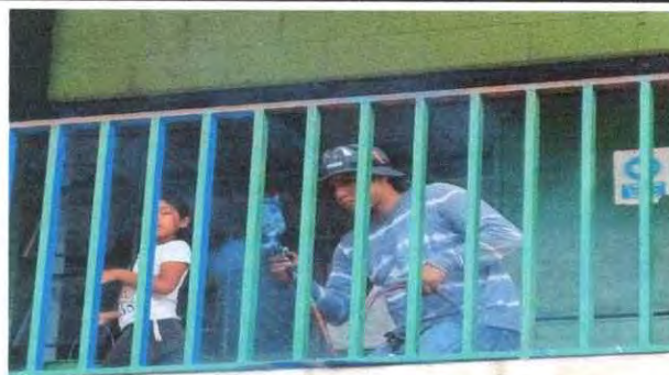
Foto 4: lijado y pintado de barandas
