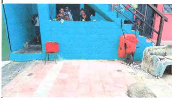
Foto 4: Colocacion de 2 pilas
