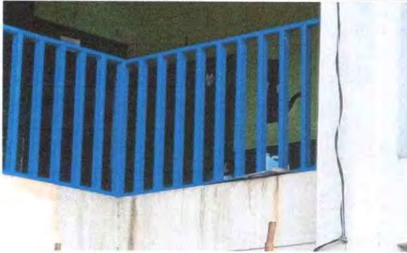
Foto1: pintura de barandas
