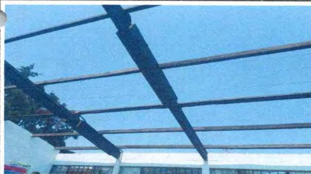
Foto 5: desmontando la vigas de madera
