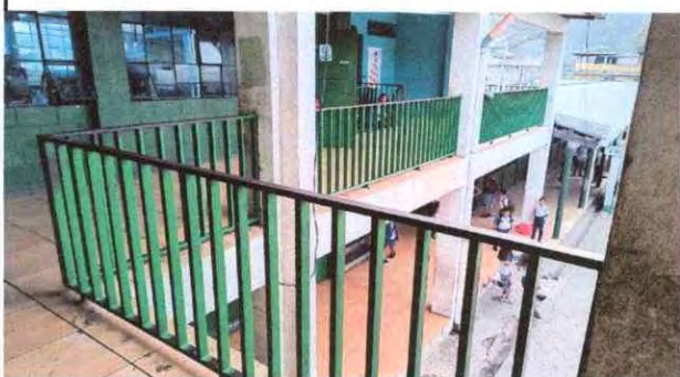
Foto 3: pintar y ajustar barandas de segundo nivel
