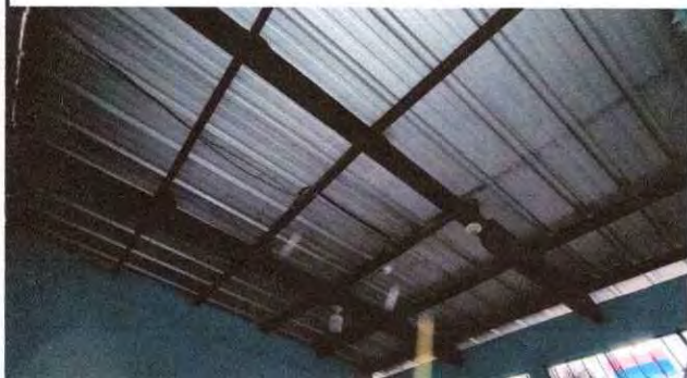
Foto1: sustitucion de vigas y laminas
