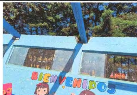
Foto 6: estructura de metal de techo.
