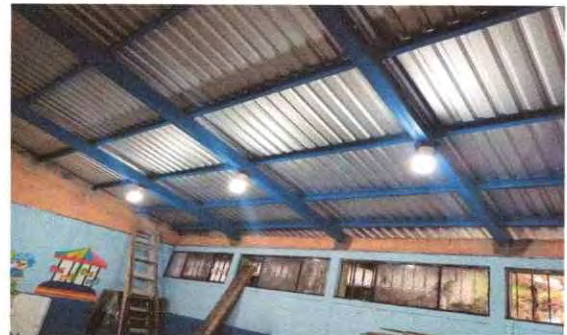
Foto 4: instalacion de laminas y estructura metalica e intalacion electrica
