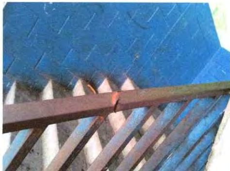
Foto 2: sustitucion de baranda de gradas
