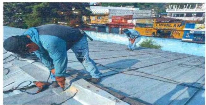
Foto 6: Desmintando el techo
