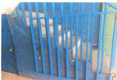
Foto 5: fabricacion de puertas de las gradas
