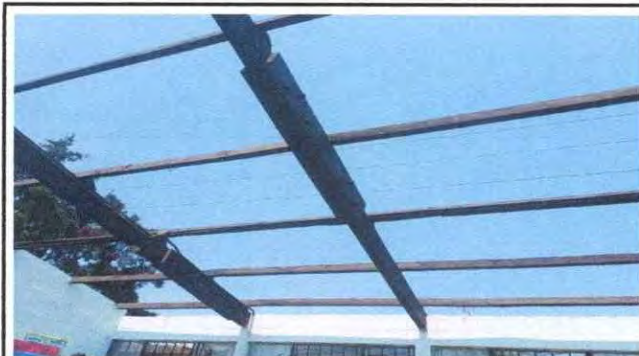
Foto 5: desmontando la vigas de madera
