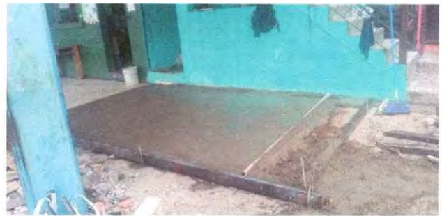
Foto 6: fundicion de tota para colocar las pilas
