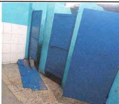
Foto 3: lijado y pintado de puertas de sanitarios
