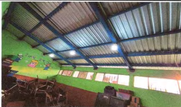
Foto1: sustitucion de vigas y laminas
