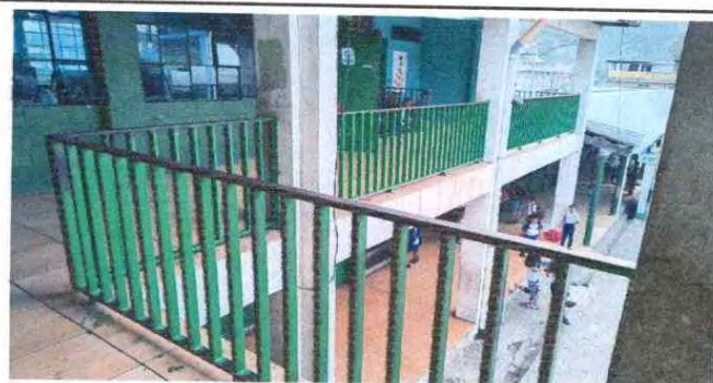
Mantenimieto de barandas de metal
