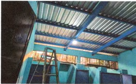
Foto 3: techo de los sanitarios
