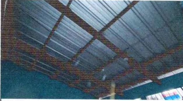
Foto1: sustitucion de vigas y laminas
