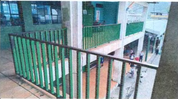
Foto 3: pintar y ajustar barantas de segundo nivel
