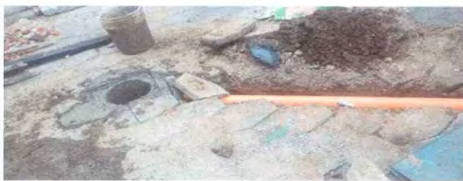
Foto 5: drenaje de pila
