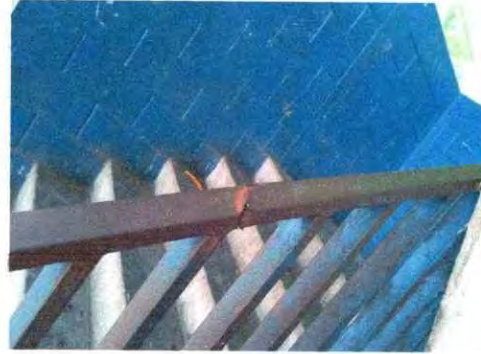
Foto 2: sustitucion de baranda de gradas
