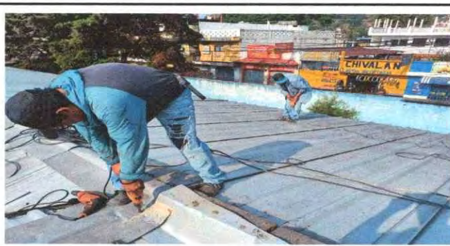
Foto 6: Desmintando el techo
