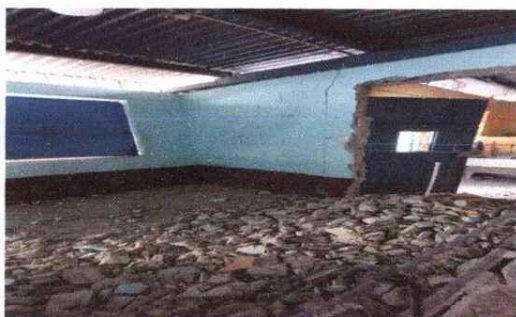
Foto1: Se demolieron esas paredes internas para hacer más amplio el espacio.
