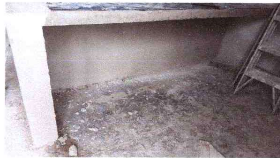
Foto 2: construcción de desayunadores
