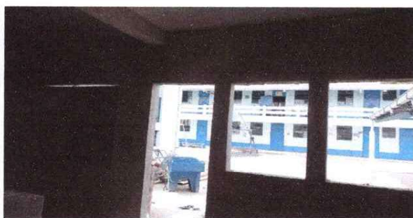
Foto 3: Construcción de nuevas ventanas.
