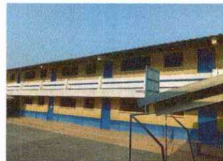
Foto 2: Ventanales por fuera
