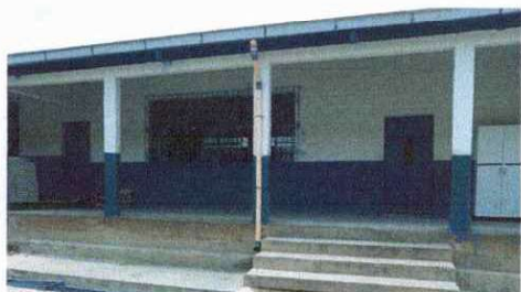
Foto 1: Ventanales y Balcones
